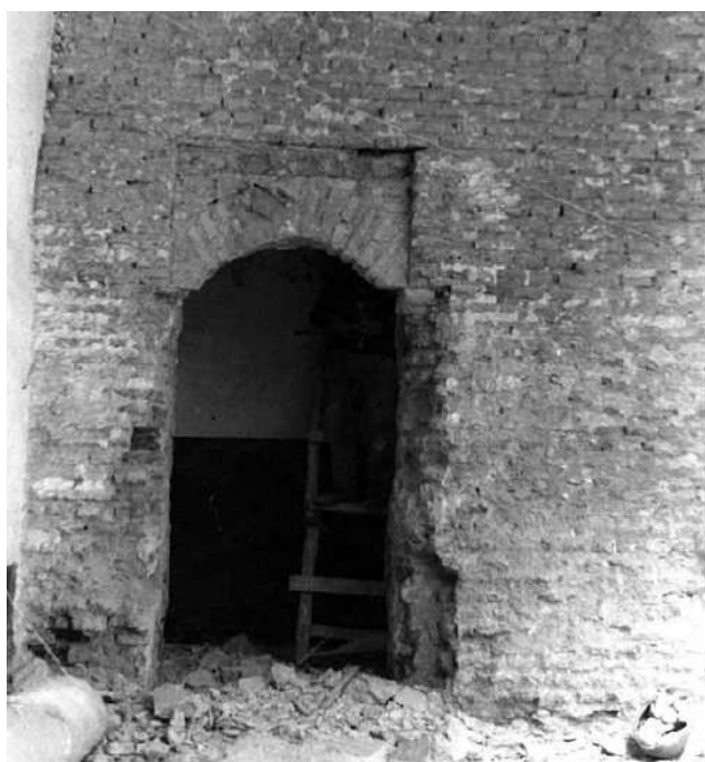
Figura 29. Puerta de acceso al minarete desde el patio de abluciones antes de ser restaurada (Berges, 2007: 91).
