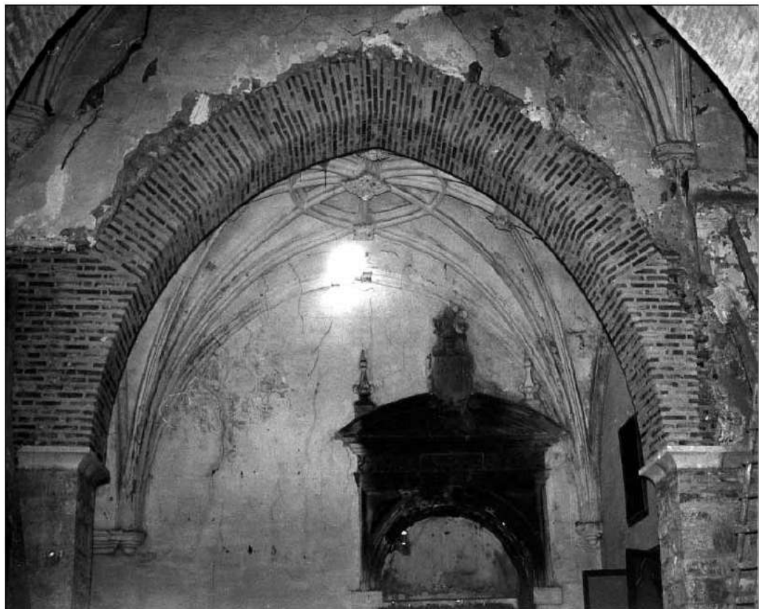
Figura 23. Arco apuntado restaurado con fábrica de ladrillo (Berges, 2007: 84).
