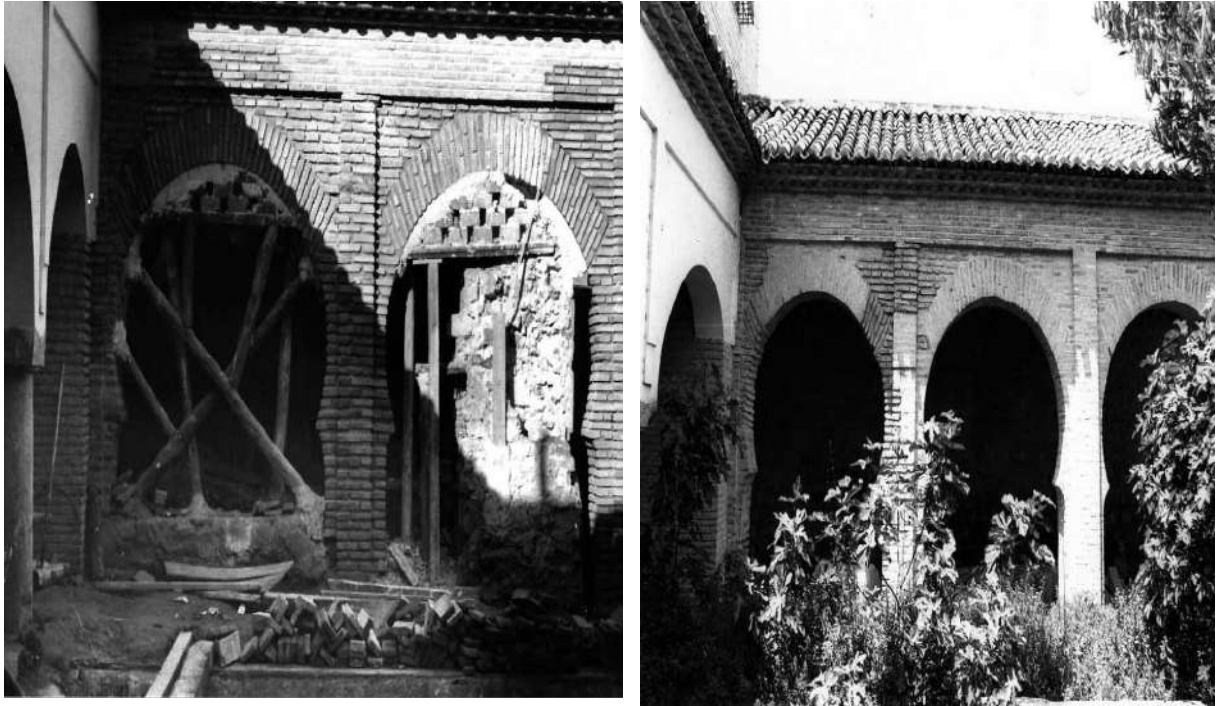
Figura 32. (Izquierda) Proceso de restauración de la arquería norte del patio de abluciones, cegada por la mampostería del muro. (Derecha) Resultado final de la arquería restaurada, diferenciado las fábricas existentes de las restituidas.
