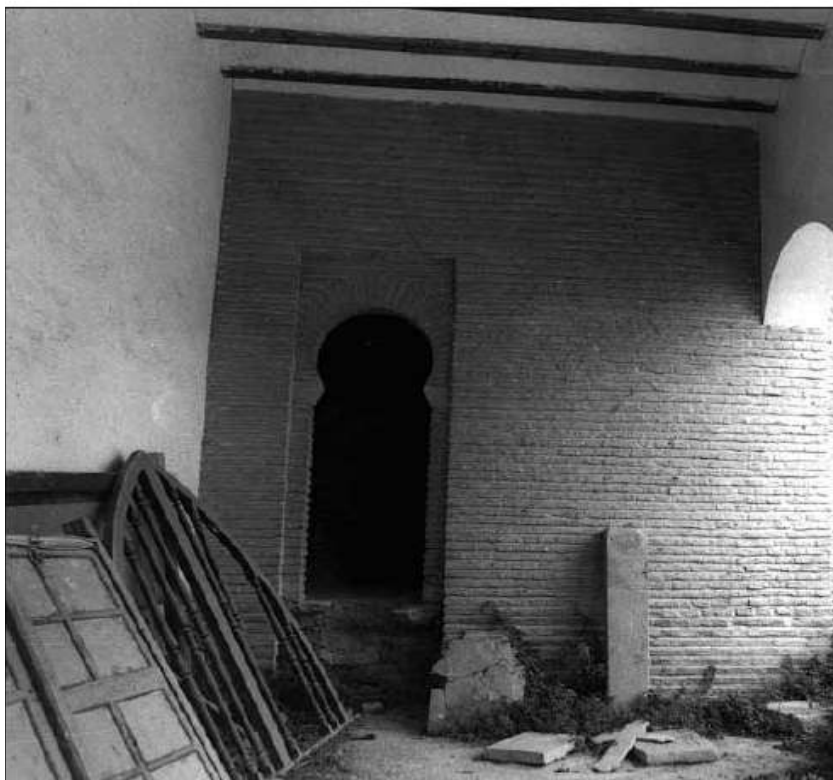
Figura 30. Fábrica y puerta del minarete restauradas tras la intervención de 1971 en la iglesia de la Magdalena (Jaén) (Berges, 2007: 91).
