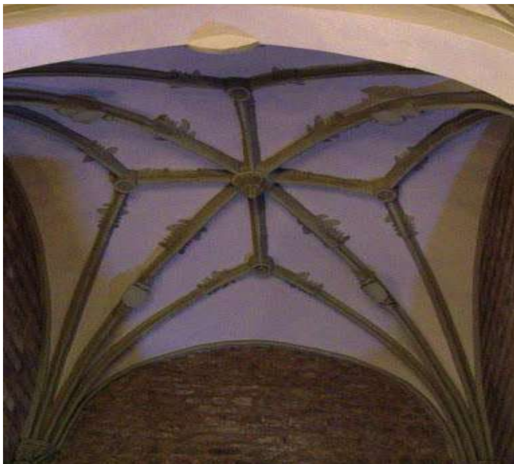
Figura 18. Bóveda central de la iglesia de la Magdalena (Jaén) de terceletes con ligaduras. (Fuente: http://www.redjaen.es/francis/?m=c&o=9365&letra=&ord=&id=59968 )
