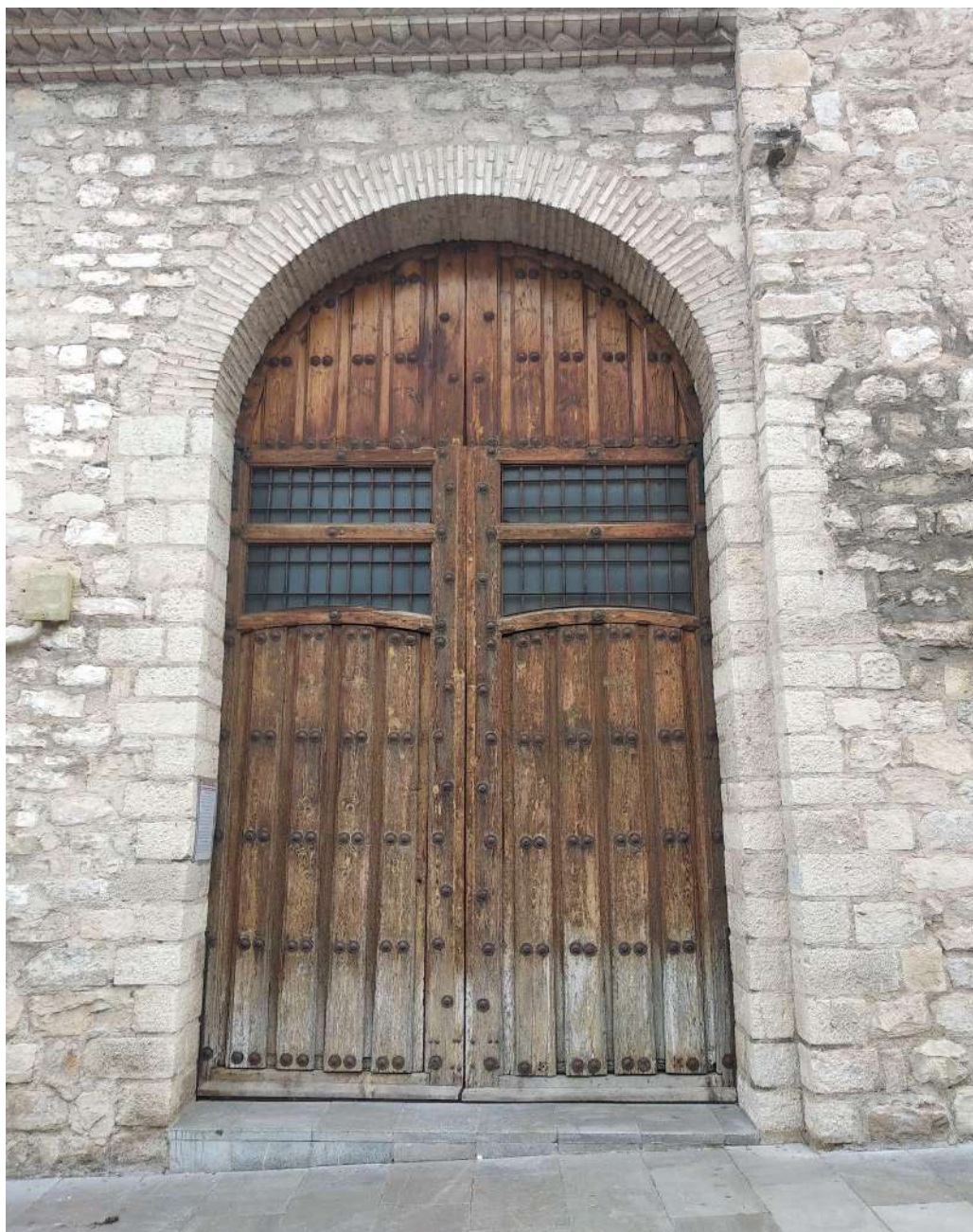
Figura 10. Puerta secundaria compuesta por dos hojas de la fachada sur de la iglesia de la Magdalena (Jaén). (Fuente de elaboración propia).
