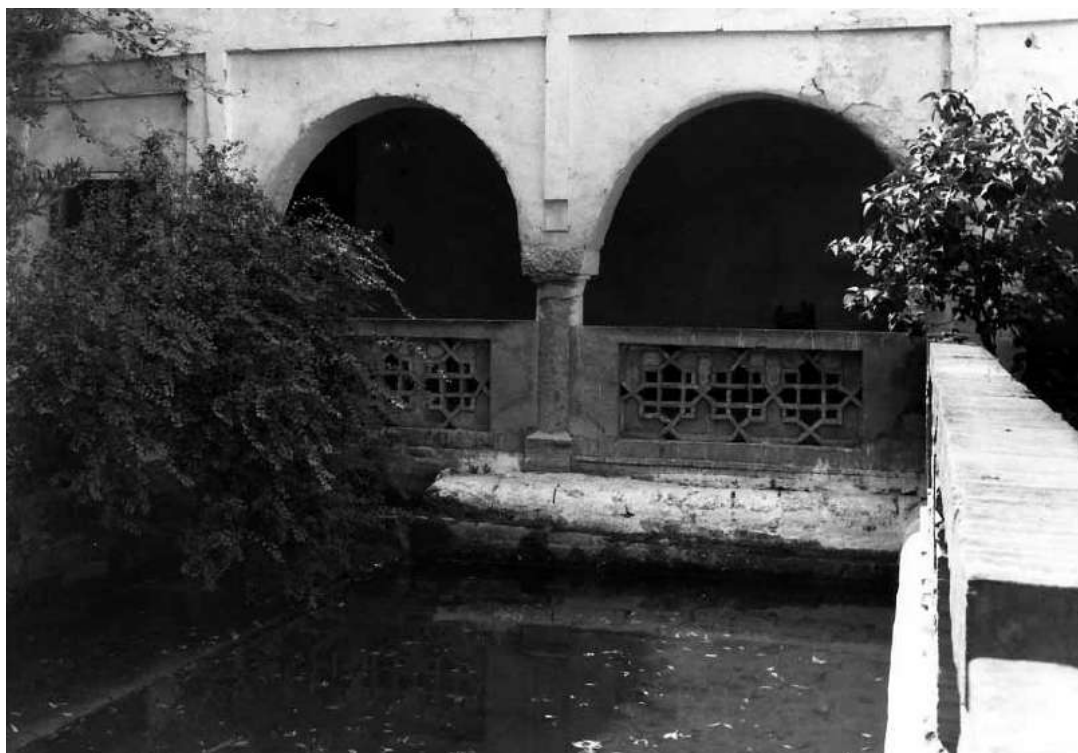
Figura 21. Aspecto del patio lateral de la iglesia de la Magdalena antes de ejecutarse las obras de restauración de 1968 (Berges, 2007: 78)
