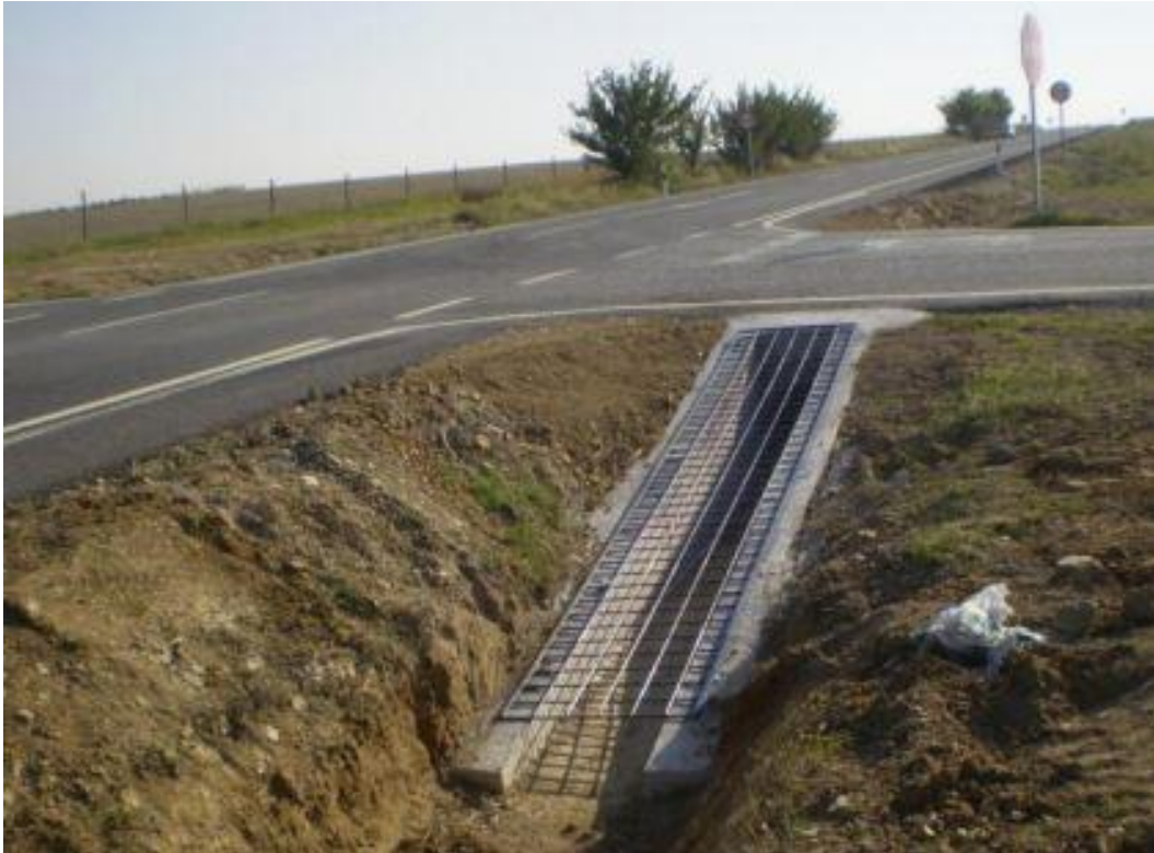
Figura 18: Ejemplos de dispositivos de protección de pasos salvacunetas de sección mallada.
