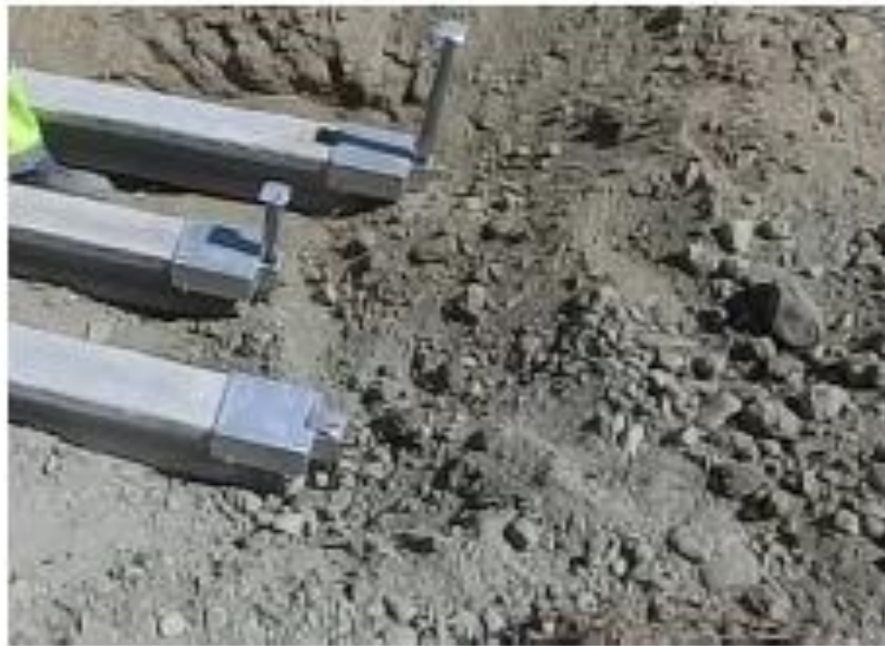
Figura 9: Hincado en el terreno.
