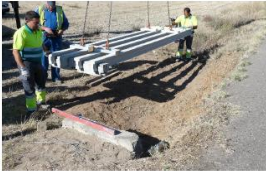
Figura 16: Manipulación de un sistema de protección formado por dos módulos.
