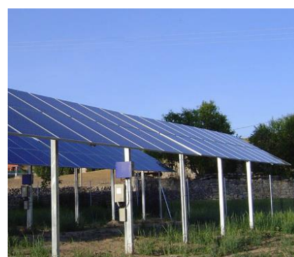
Figura 68.- Instalación elementos de monitorización.
