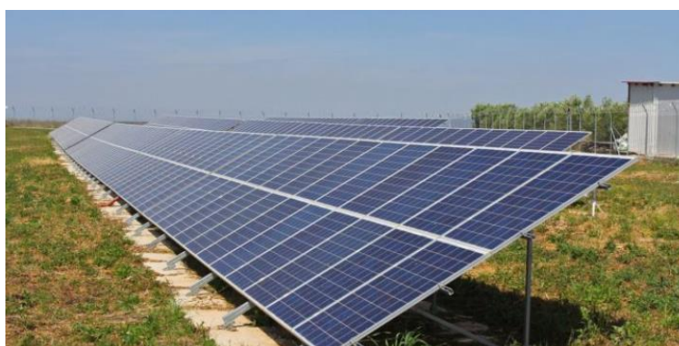
Figura 67.- Montaje de módulos fotovoltaicos.
