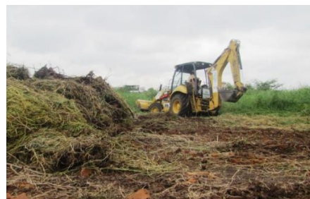
Figura 61.- Desbroce y limpieza de terrenos.
