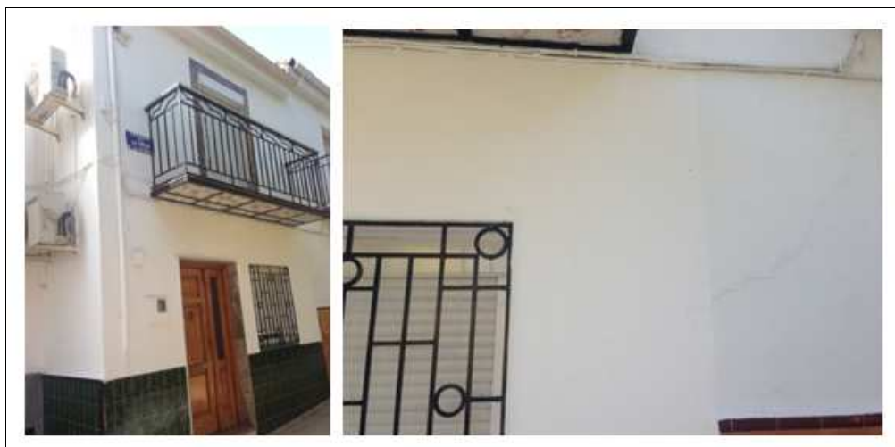
Figura 4.17. Fachada 11 visiblemente rehabilitada.
