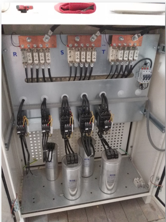
Ilustración 20: Batería de condensadores para alta tensión.
