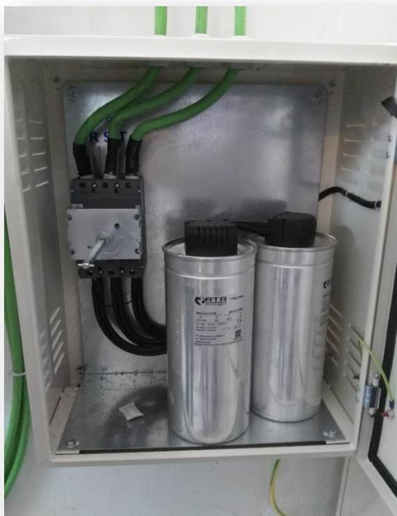
Ilustración 19: Batería de condensadores para baja tensión
