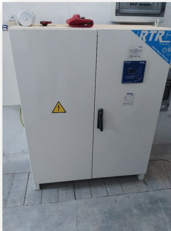
Ilustración 20: Batería de condensadores para alta tensión.
