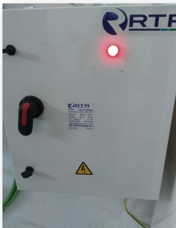
Ilustración 19: Batería de condensadores para baja tensión
