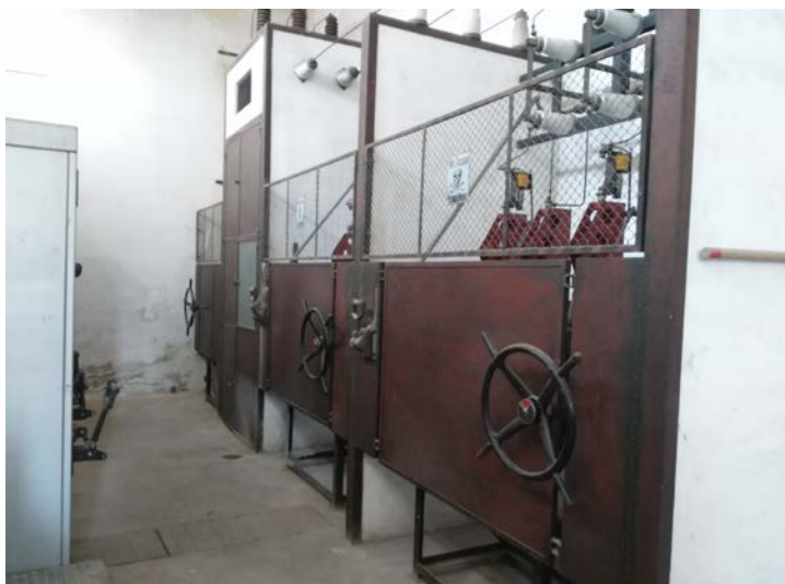
Ilustración 18: Centro de transformación IES El Valle.
