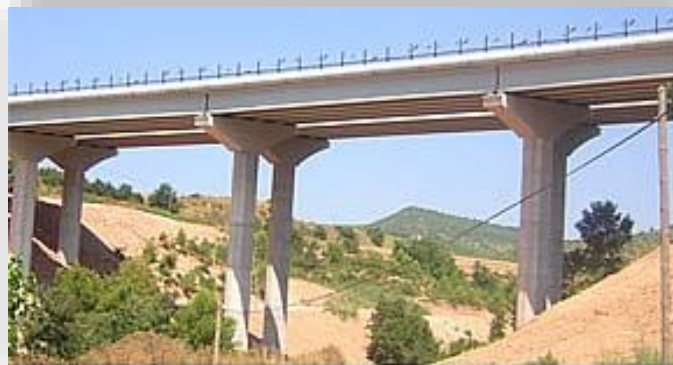
Figura 3.1. Puente de Vigas. [14]
