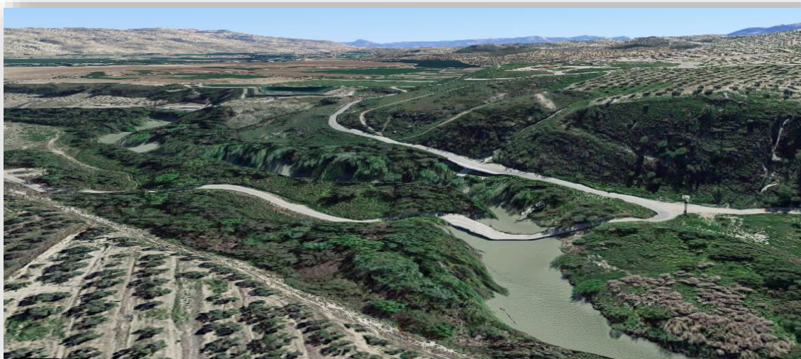
Figura 2.1. Localización de la Estructura.
