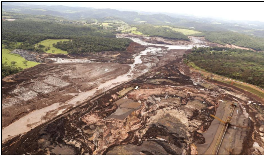
Figura 1-8. Inundación provocada por la rotura de las presas mineras en Minas Gerais (Brasil). Fuente: https://elpais.com/elpais/2019/01/25/album/1548447082_456992.html
