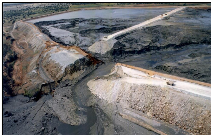
Figura 1-7. Brecha en la presa de residuos mineros en el desastre de Aznalcóllar (Andalucía). Fuente: https://elpais.com/elpais/2018/04/20/album/1524211696_728584.html#foto_gal_12
