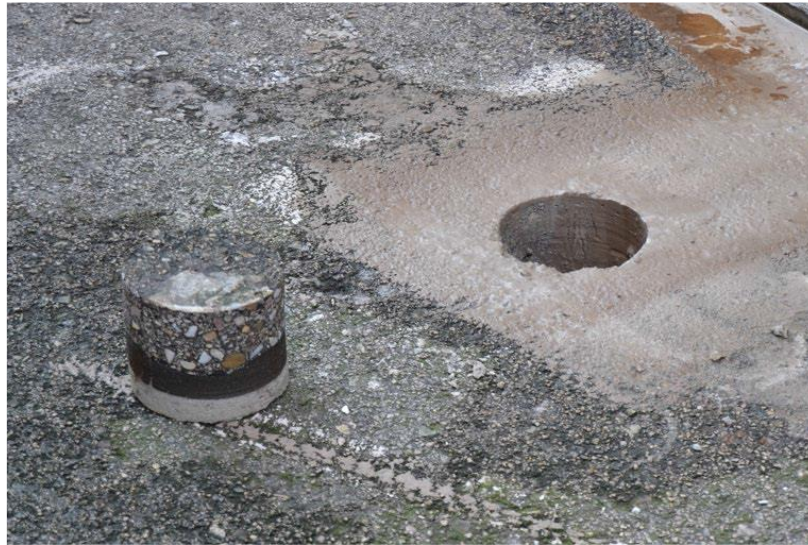
Figura 3.8 Agujero final para la instalación.
