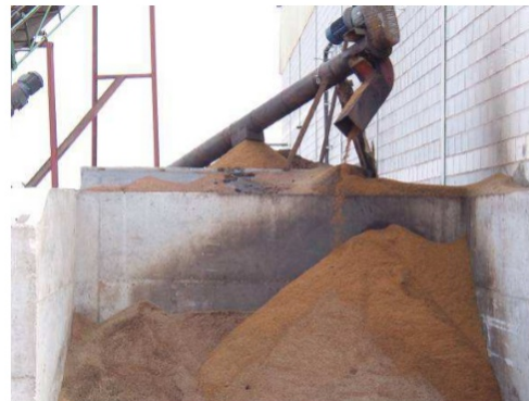
Figura 3.3 Detalle separación pulpa-hueso de aceituna. [5]
