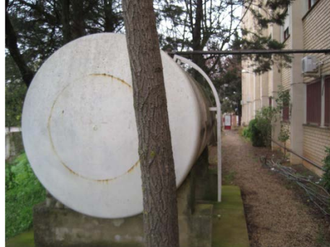
Figura 4.3 Fotografía de la ubicación de depósito de gasóleo a desmontar. [14]
