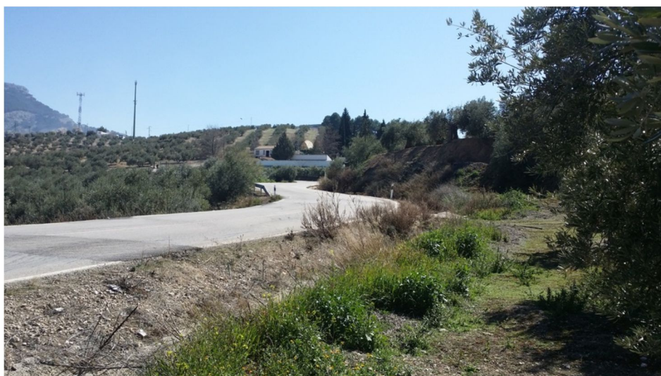
Figura 4. Carretera que une la salida 46 de la Autovía A-44 con La Guardia de Jaén en la actualidad
