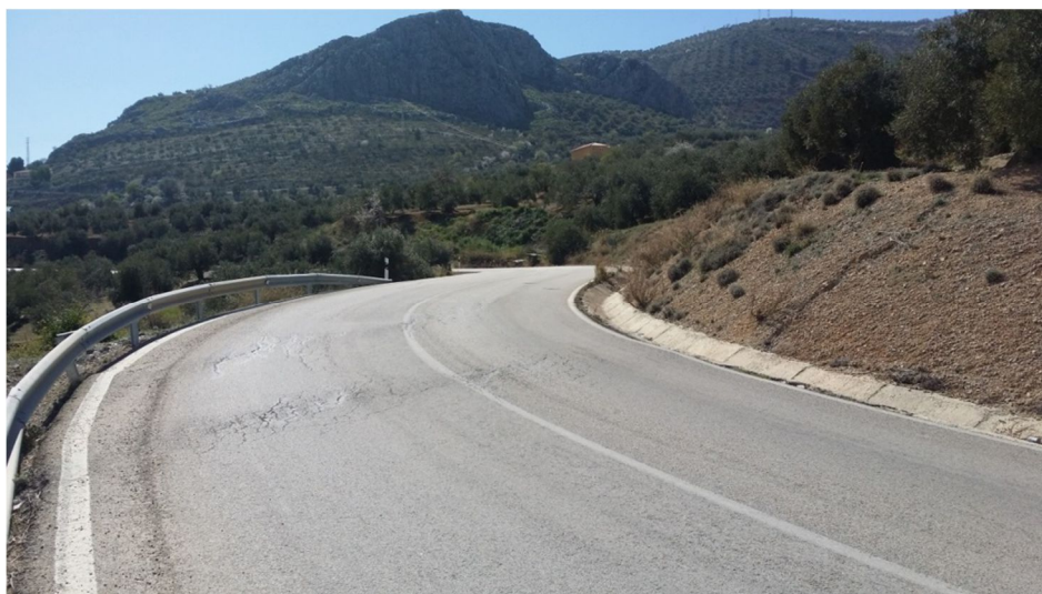
Figura 3. Carretera que une la salida 46 de la Autovía A-44 con La Guardia de Jaén en la actualidad
