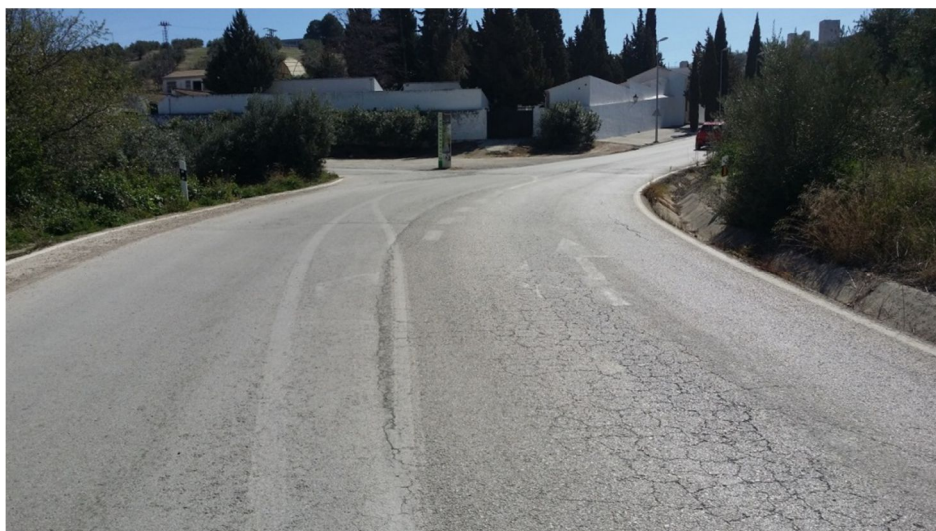
Figura 5. Cruce de la Carretera que une la salida 46 de la Autovía A-44 con La Guardia de Jaén en la actualidad con la Calle Escuelas
