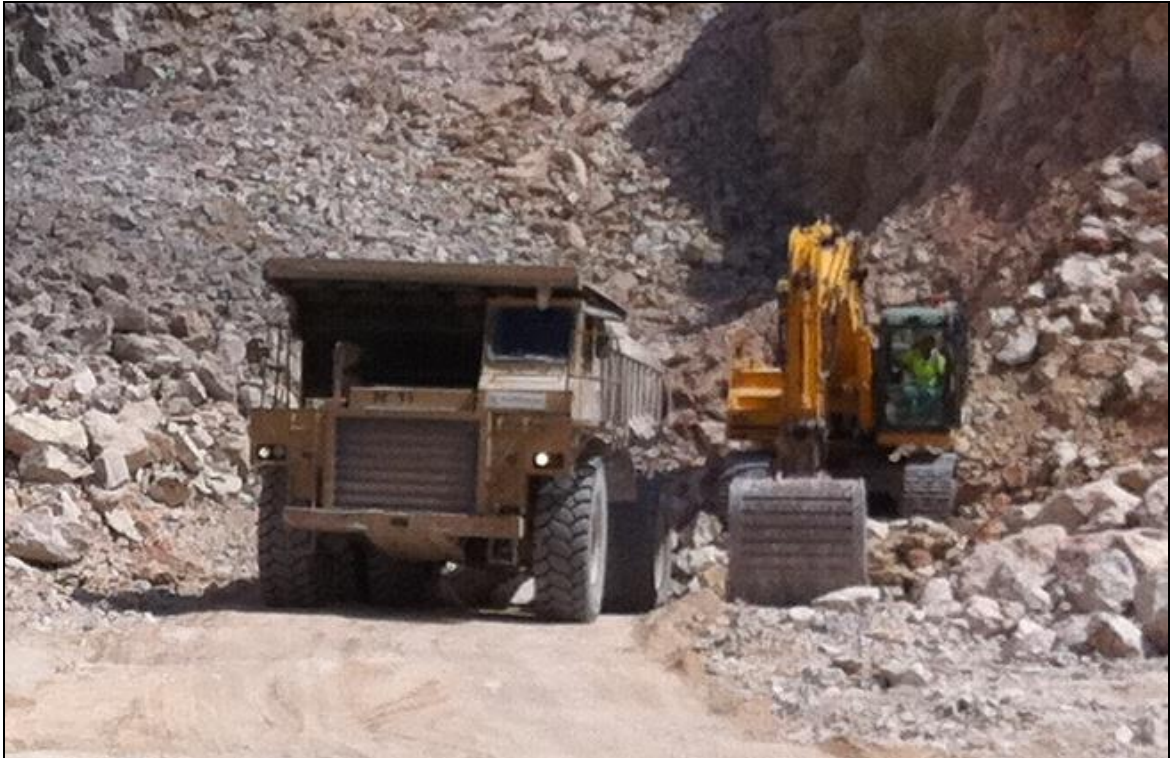
Figura 8.28. Retroexcavadora cargando de la banqueta.
