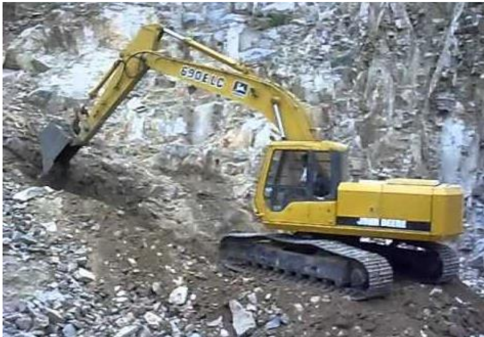
Figura 6.2 Retro cargando en el frente.
