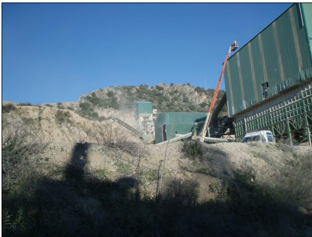
Figura 8.7. Salida de producto terminado.
