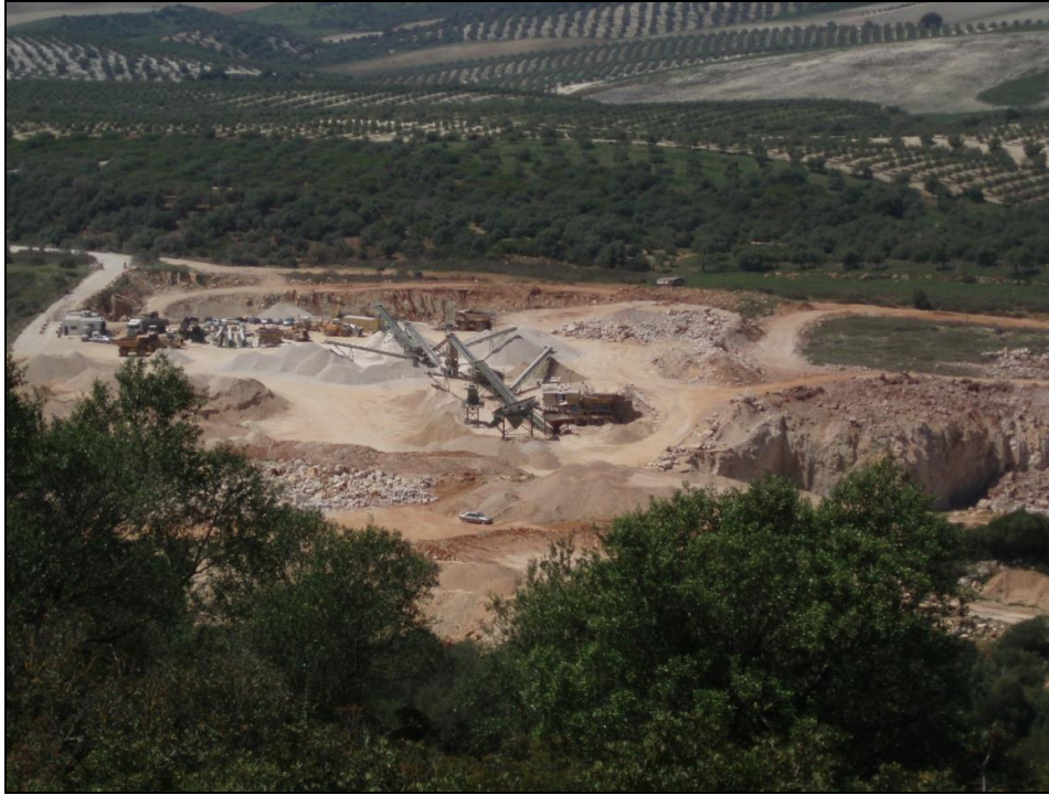
Figura 8.35. Vista general de la planta
