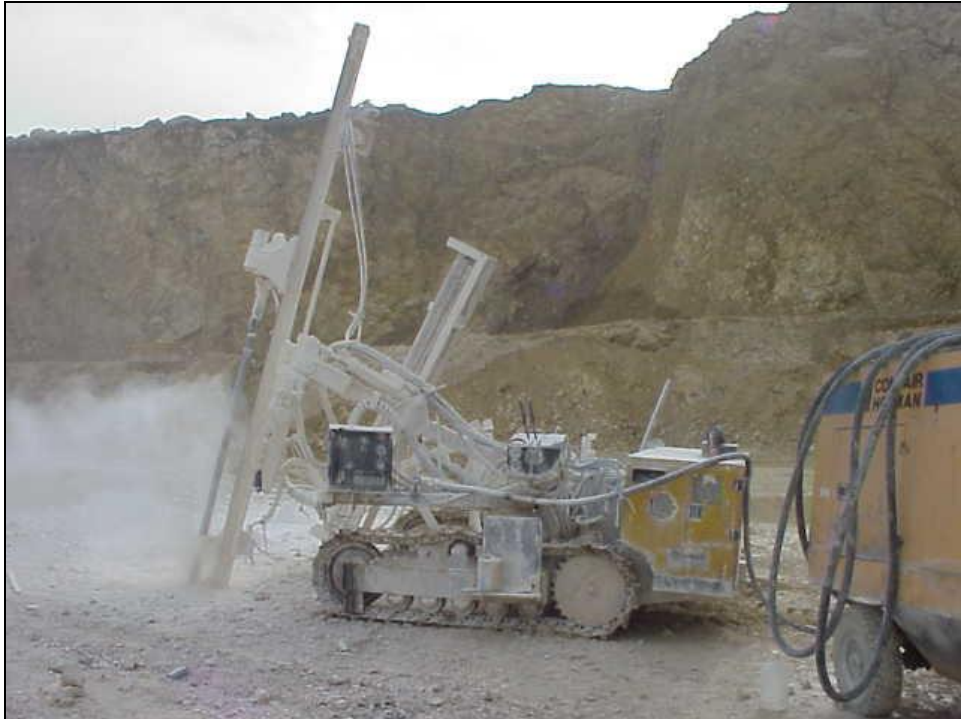
Figura 8.13. Equipo de perforación, martillo sobre orugas y compresor.
