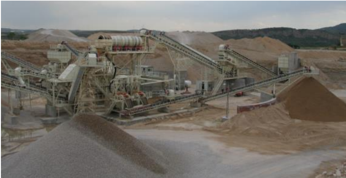
Figura 7.1. Vista general de una planta de fabricación de áridos
