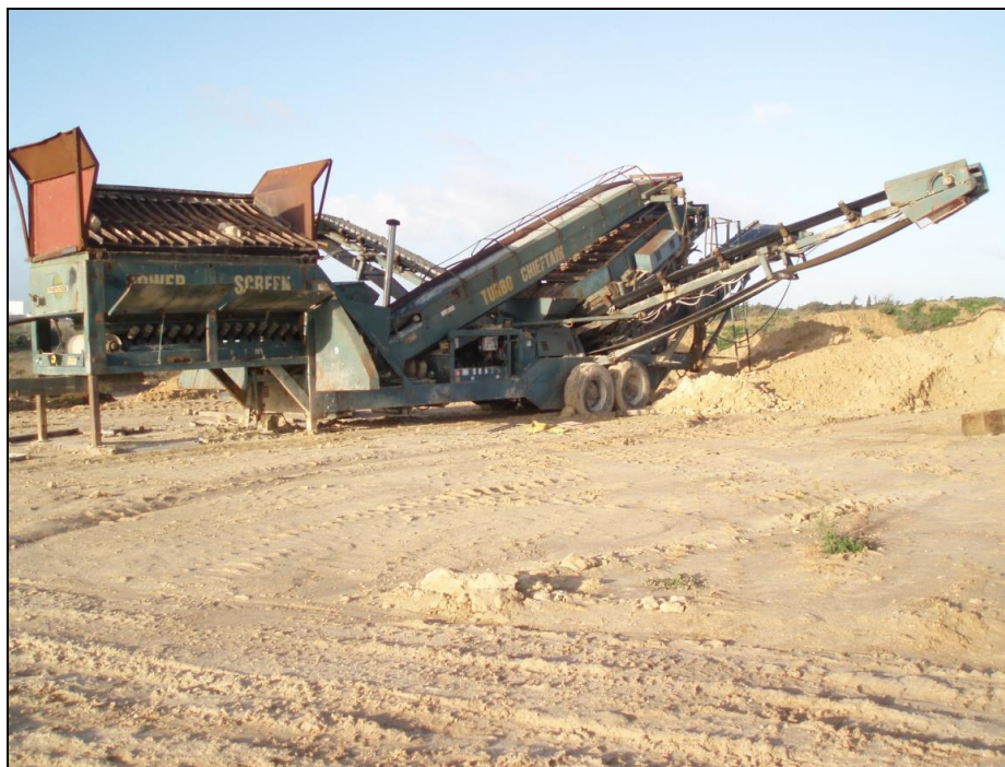
Figura 8.52. Vista general de la planta móvil.
