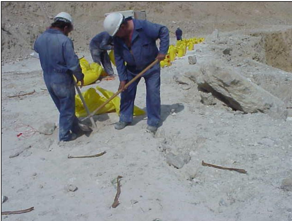
Figura 8.11. Carga de barrenos para voladura.
