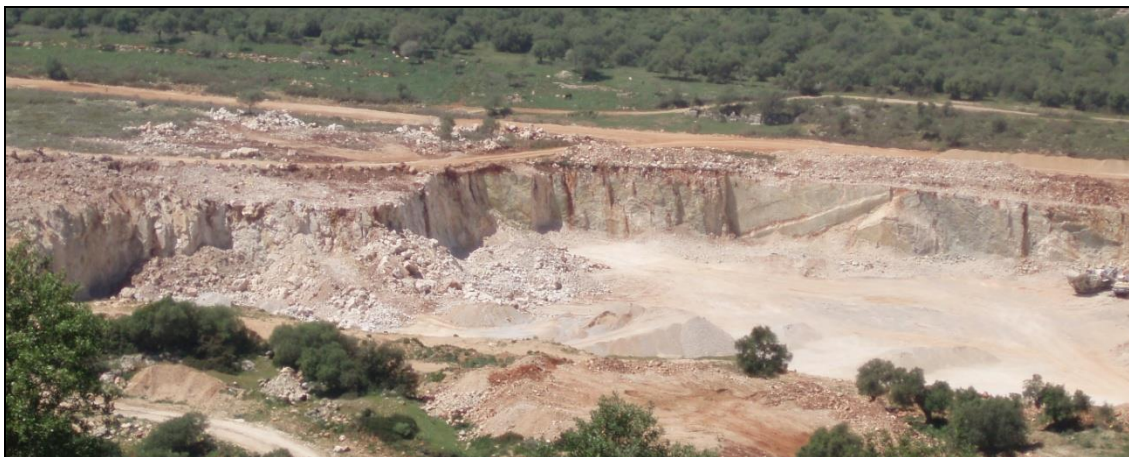
Figura 8.33. Frente de explotación banqueado
