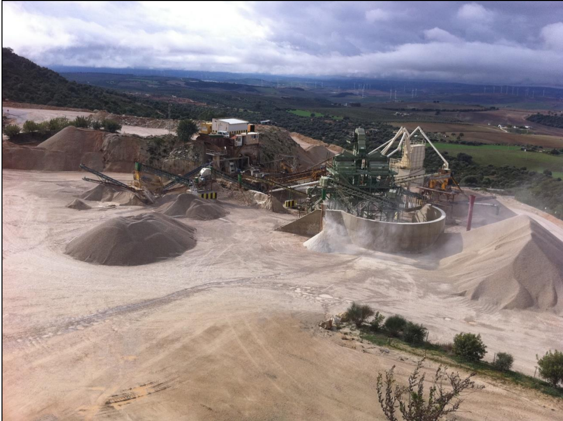
Figura 8.29. Planta de fabricación de áridos.
