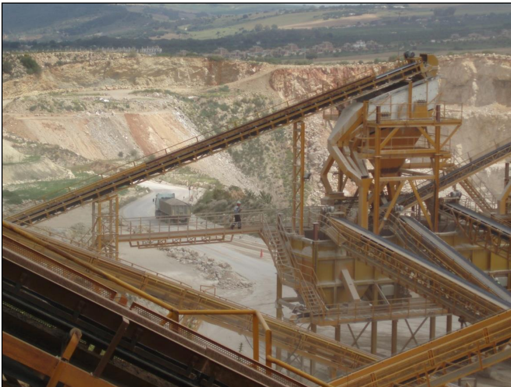
Figura 8.18. Almacenamiento en silos de producto terminado.
