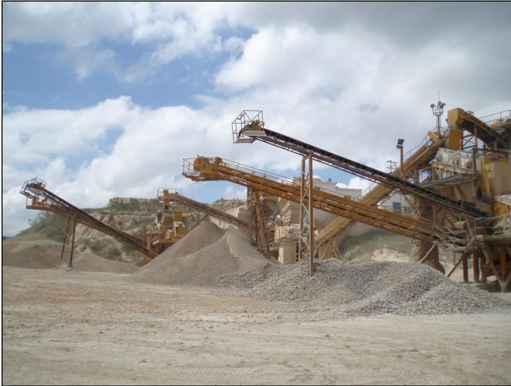
Figura 8.17. Salida de producto terminado.
