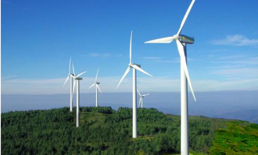
Figura 2: Parque eólico de Serra do Burgo (Orense, España)
