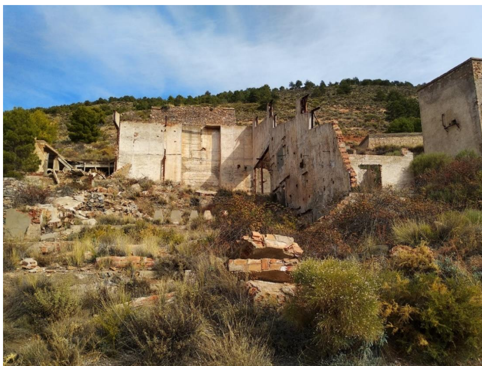
Ilustración 66. Edificios para los trabajadores.
