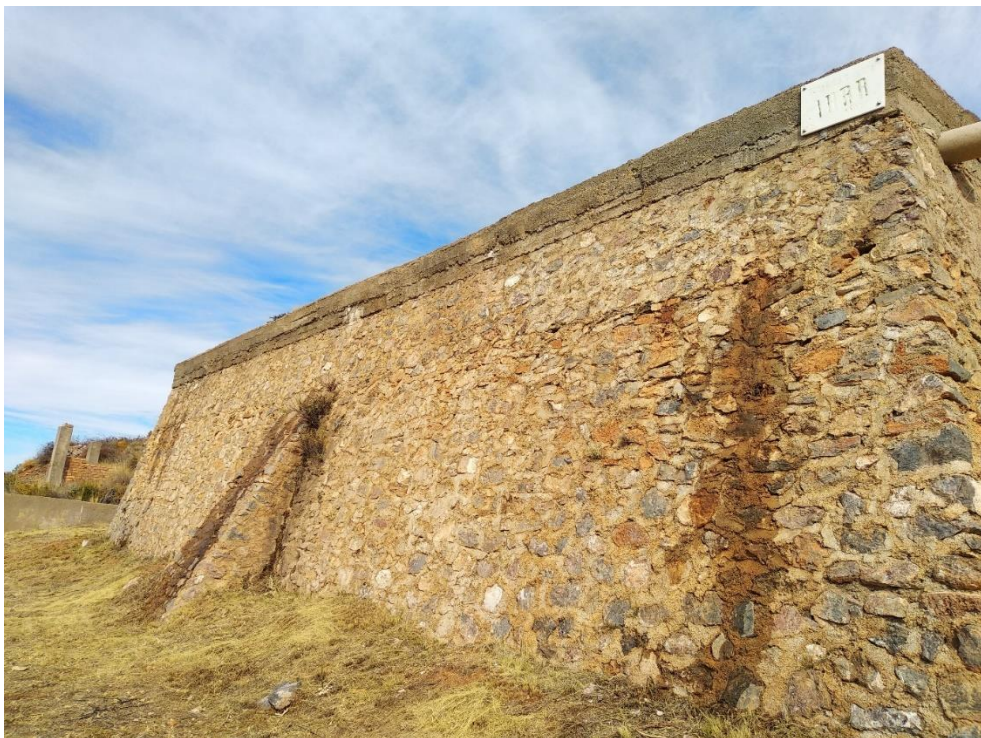
Ilustración 64. Tolla de mampostería.
