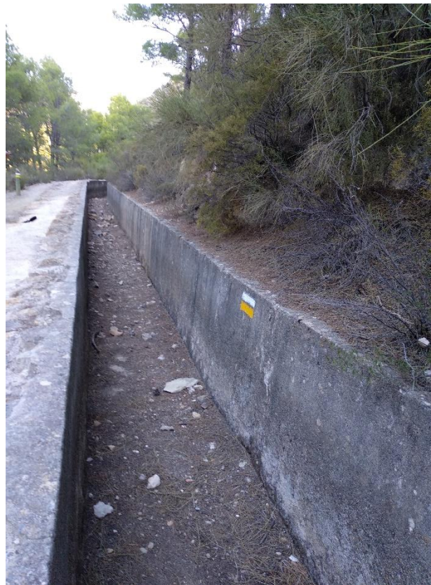
Ilustración 73. Señalización sobre cemento.
