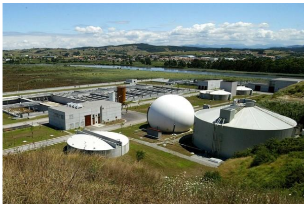
Imagen 11. Depuradora de agua en Suances.
