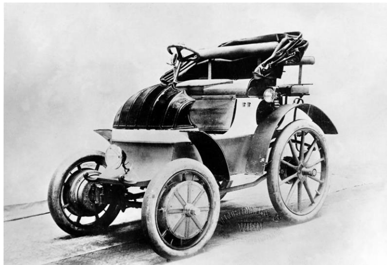
Figura 1. Lohner Porsche eléctrico (y tracción delantera) de 1898
