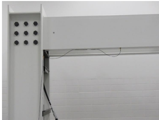
Figura 68. Acelerómetros pegados en el marco.
