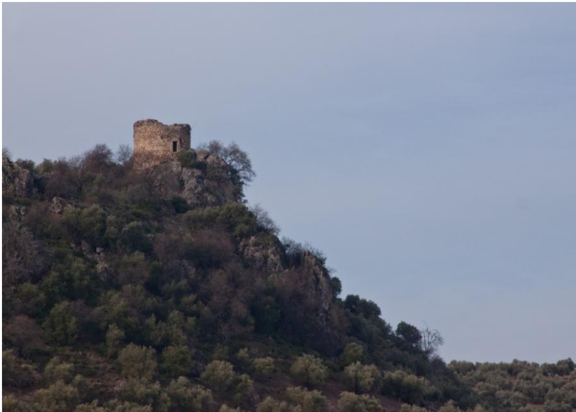
Lámina 14: Torre Olvidada. Fuente: http://castillosyfortalezasdejaen.com/castillos/29-torre-olvidada.html
