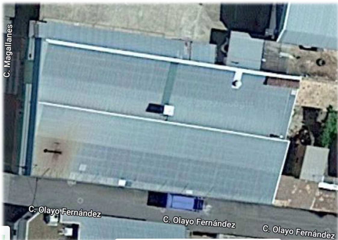
Ilustración 4 Tejado de la instalación
