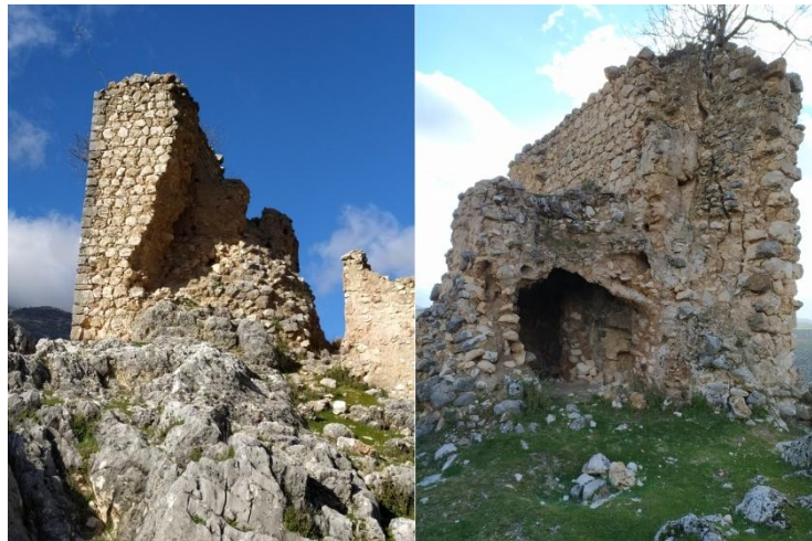
Figura 56. Torre sur con el espacio habitable
