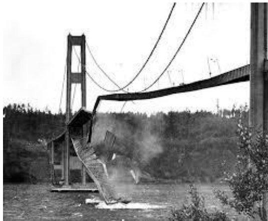
Figura 2.4. Colapso del puente de Tacoma Narrows, por la vibración producida por el viento.
