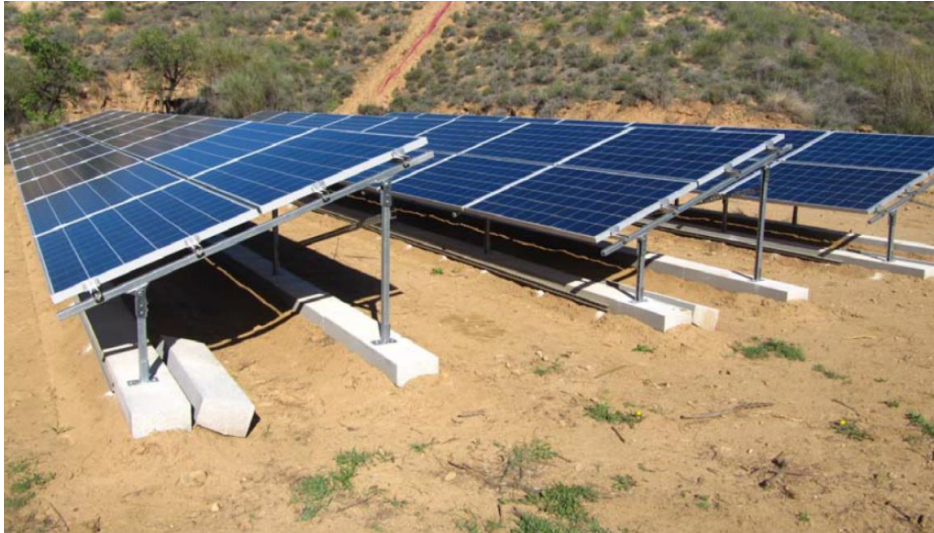
Figura 6.23 Posible solución de anclaje al suelo
