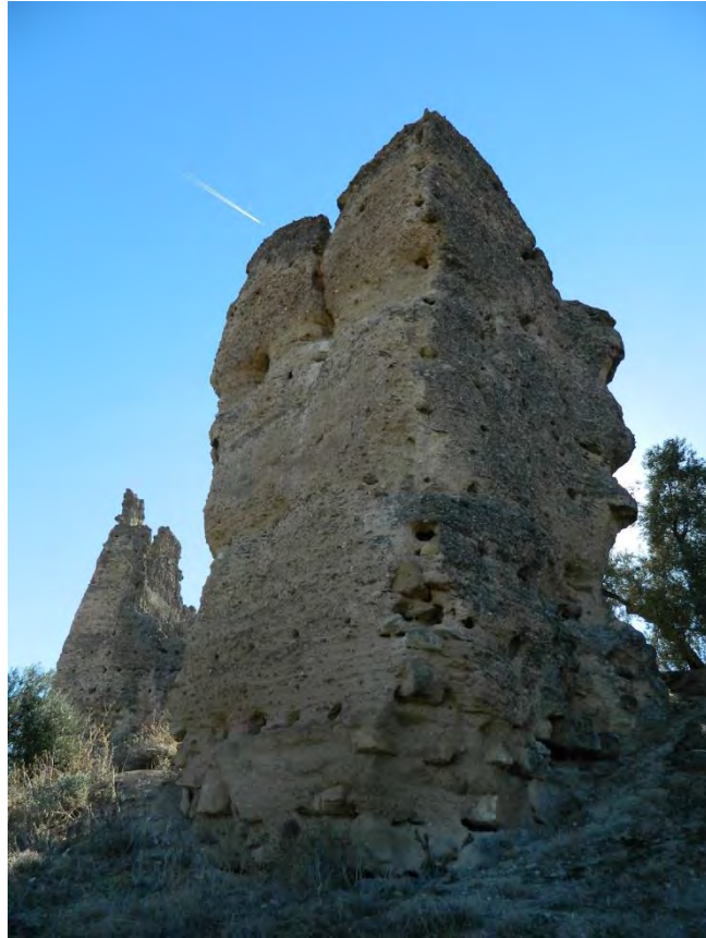
Lám. 11. Torre almohade del sector Norte de Estivel. Vista desde el exterior del cerro. Fuente: elaboración propia.
