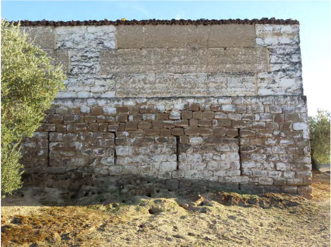
Lám. 29. Muro del cortijo de Las Huelgas, orientado al Este, que podría pertenecer a unas caballerizas. Fuente: elaboración propia.
