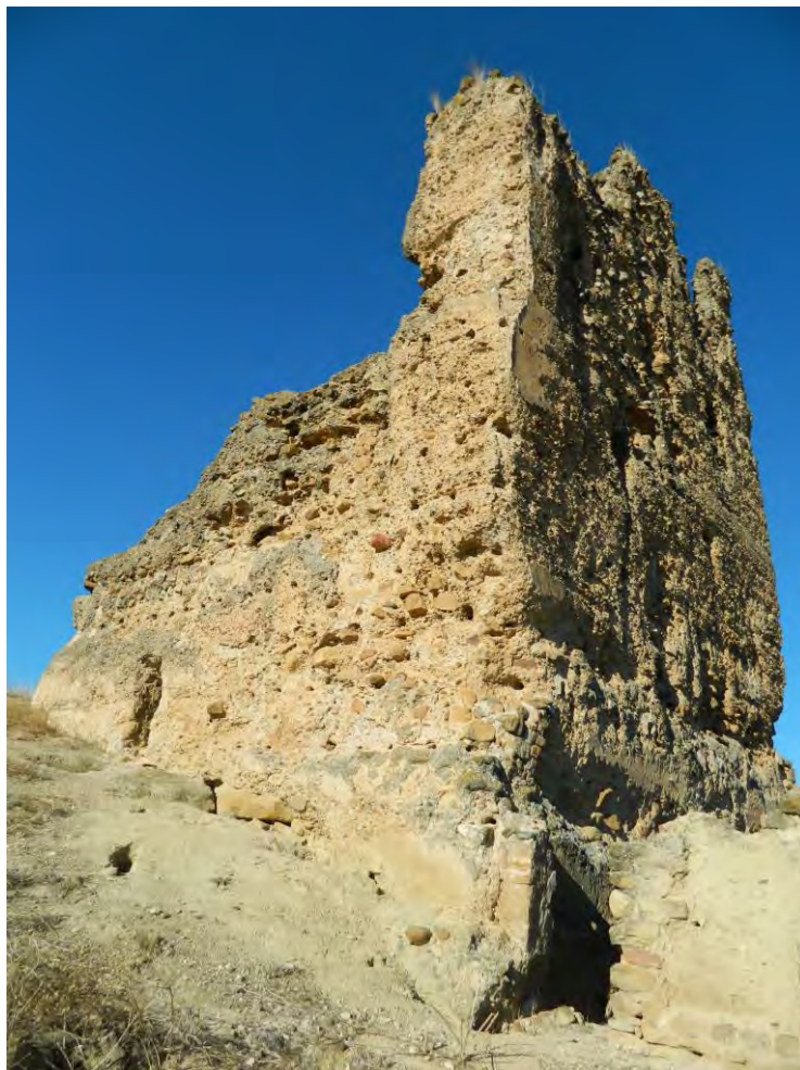
Lám. 14. Gran torre de tapial de Estiviel, situada y orientada al Este. Fuente: elaboración propia.
