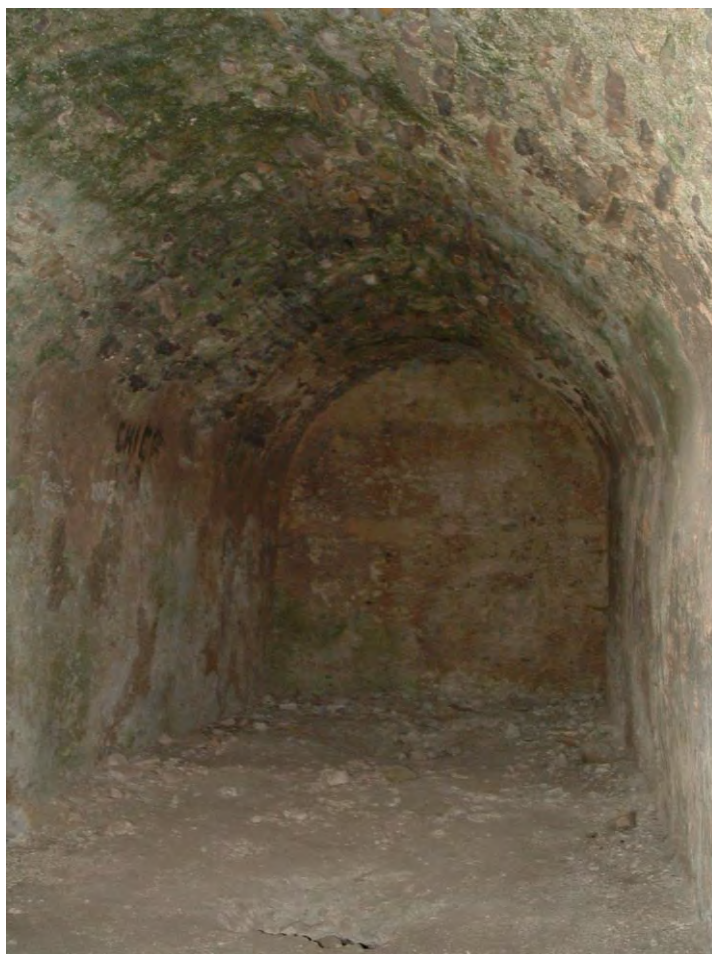
Lám. 17. Aljibe de la planta baja de la torre de Estiviel, con restos de enlucido. Fuente: Juan Carlos Castillo Armenteros.
