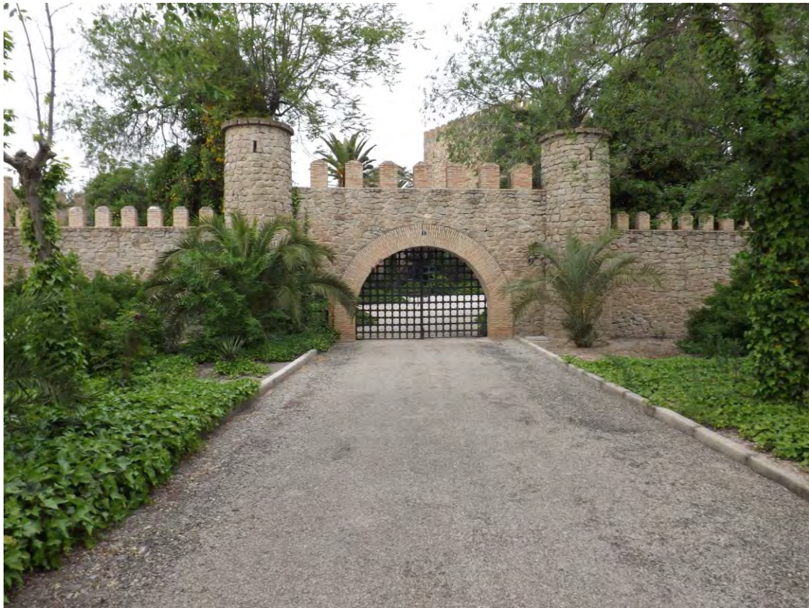
Lám. 35. Cerca con torreones y verja de acceso al Castillo de Espelúy. Fuente: elaboración propia.
