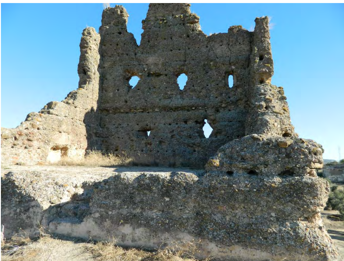
Lám. 16. Cara interna de la gran torre de tapiel de Estiviel. El aljibe está en el nivel inferior. Fuente: elaboración propia.
