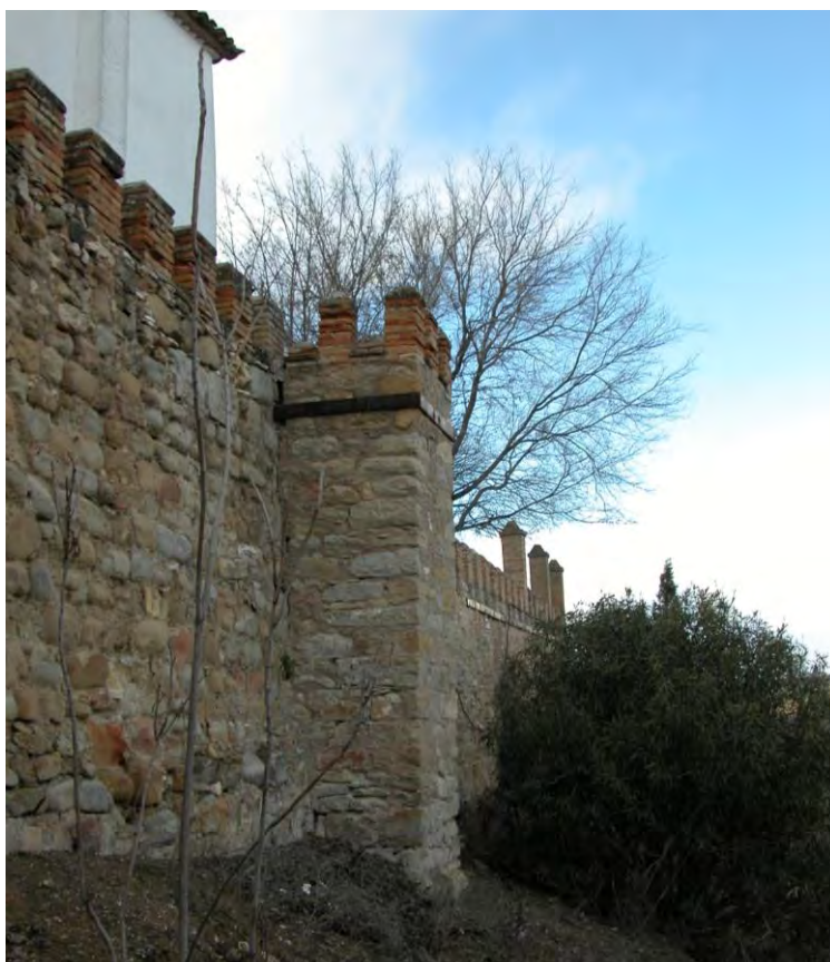
Lám. 40. Pequeño torreón de refuerzo del muro Este del Castillo de Espelúy, en este caso con un elemento metálico en la parte superior. Fuente: elaboración propia.
