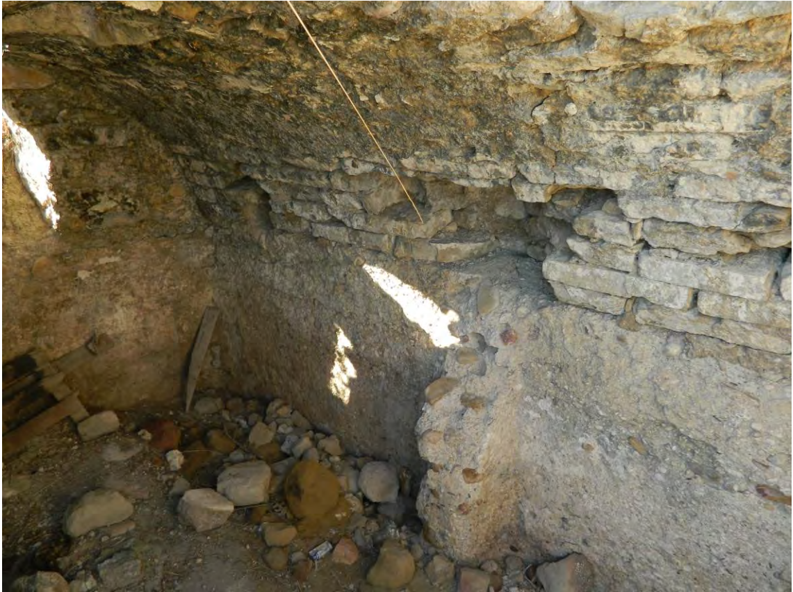
Lám. 21. Aljibe del Sur de Estiviel, con el arranque del arco fajón. Fuente: elaboración propia.
