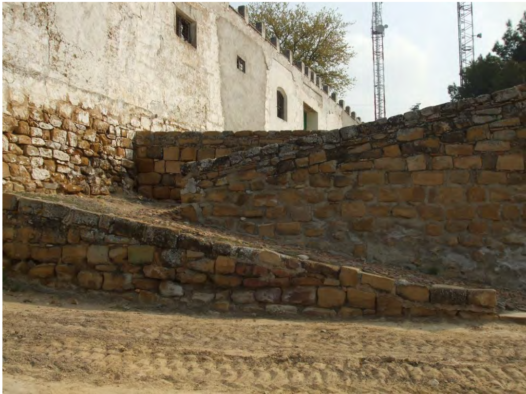
Lám. 30. Rampa de acceso al cortijo de Las Huelgas. Fuente: Juan Carlos Castillo Armenteros.
