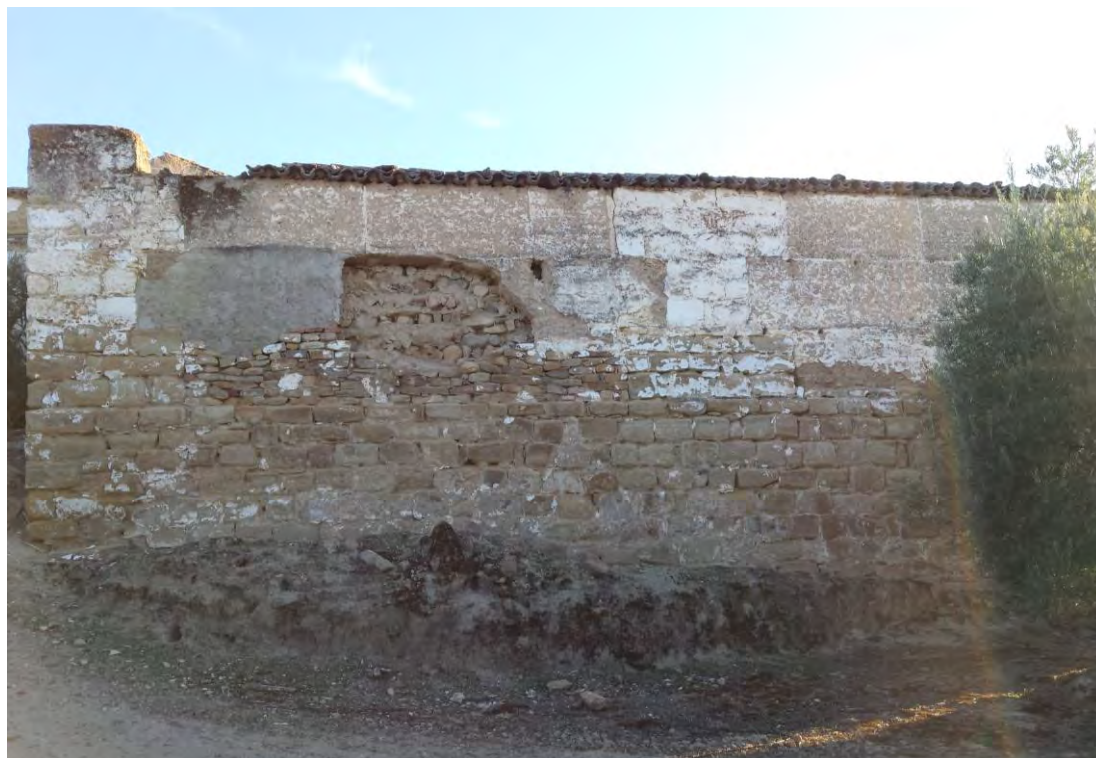
Lám. 28. Muro mixto de tapial y sillarejo del cortijo de Las Huelgas. Fuente: elaboración propia.
