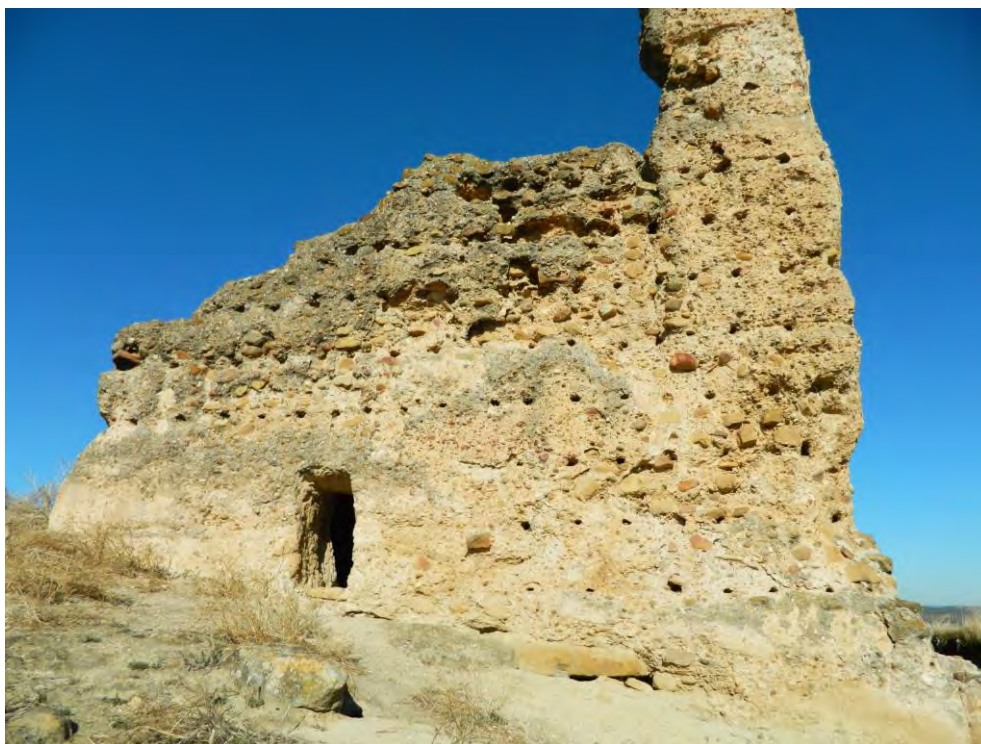
Lám. 18. Entrada al aljibe abierta en el lateral Este de la torre de Estiviel. Fuente: elaboración propia.
