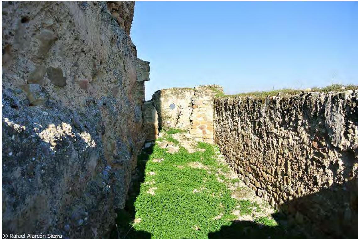
Lám. 25. Espacio creado entre el frente Norte de la torre principal de Estiviel y el muro mixto. Fuente: Rafael Alarcón Sierra.
