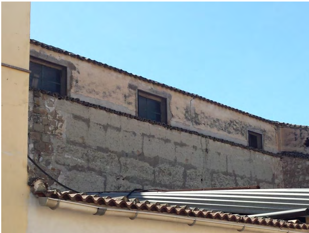
Lám. 4. Muro mixto de tapial y mampostería que traba con otro de mampostería en el solar del Castillo de Jabalquinto. Fuente: elaboración propia.
