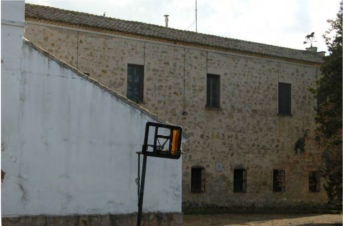
Lám. 43. Muro del Palacio de Espelúy orientado al Norte. Se aprecia claramente cómo difiere con el resto de estructuras del recinto. Fuente: elaboración propia.
