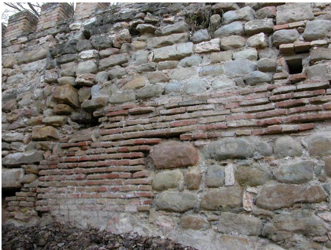
Lám. 38. Paramento de muralla del Castillo de Espelúy con un claro arreglo de ladrillo. Fuente: elaboración propia.
