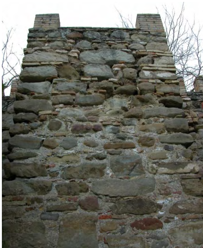
Lám. 39. Pequeño torreón de refuerzo del muro Este del Castillo de Espelúy. Fuente: elaboración propia.
