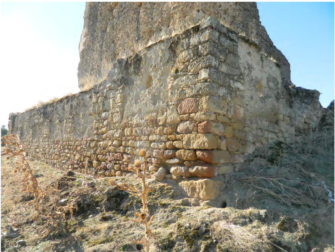
Lám. 24. Muro mixto que corre paralelo a la torre principal de tapial de Estiviel. Fuente: elaboración propia.
