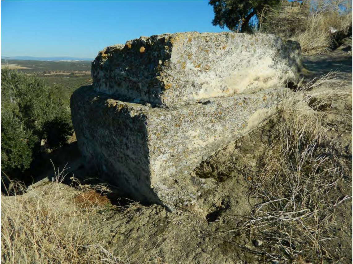
Lám. 7. Posible torre emiral-califal de Estiviel, situada al Norte. Fuente: elaboración propia.
