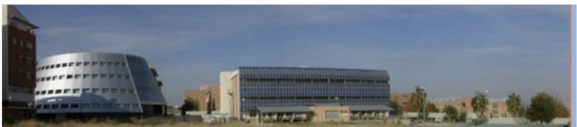
Ilustración 2.- Fotografía Instalación de Energía solar
