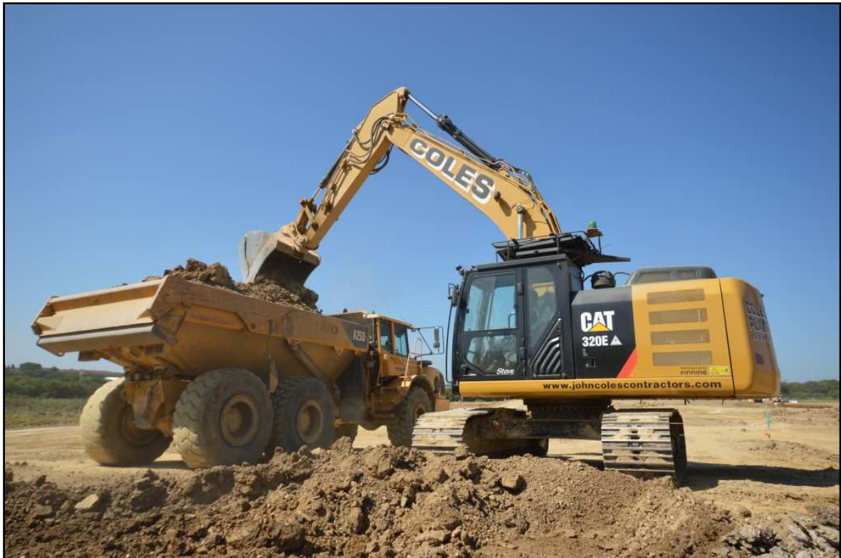
Figura nº 65 : Equipo de carga retroexcavadora sobre orugas modelo 320E de Caterpillar.
