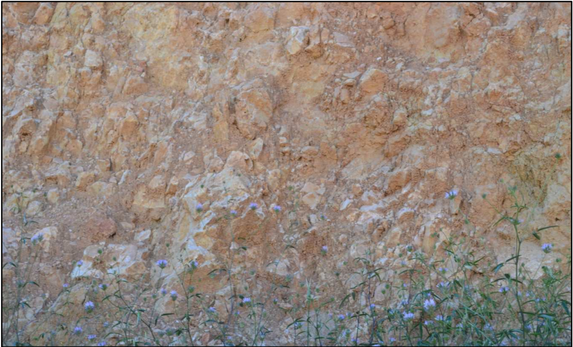
Figura nº 35 : Detalle meteorización grado III
