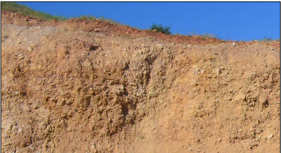
Figura nº 36 : Detalle meteorización grado IV-V
