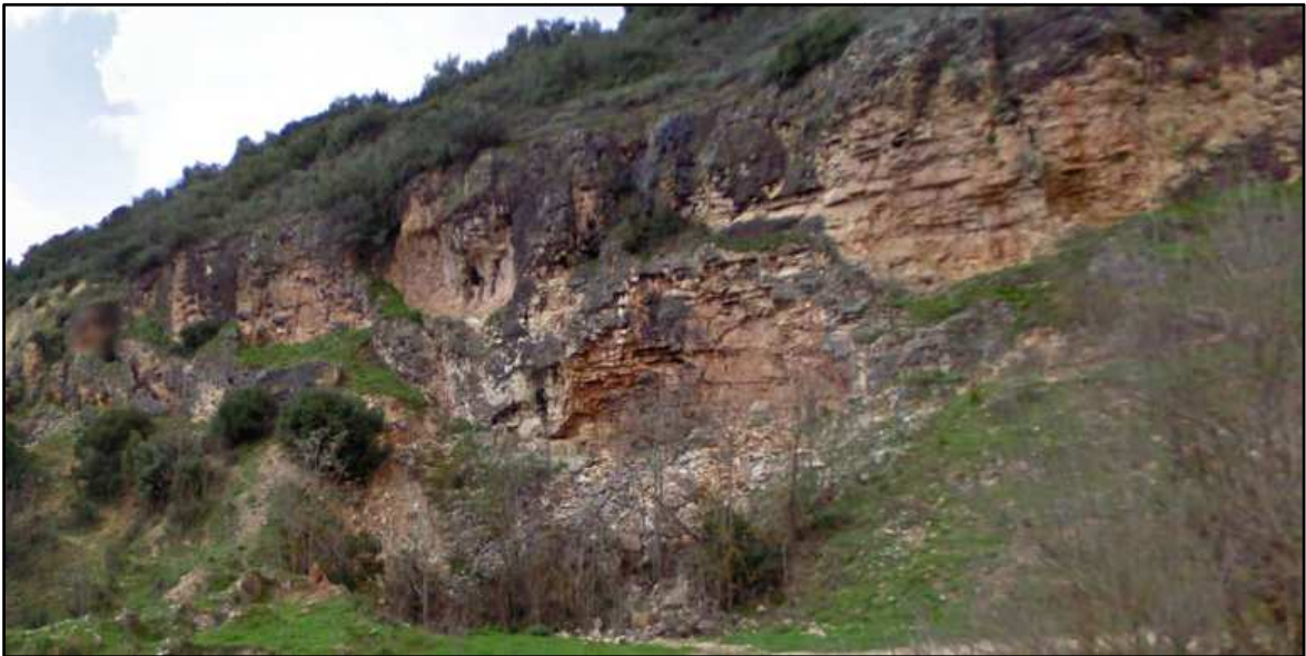
Figura nº 26 : Detalle frente localización nº 2 en la Zona B
