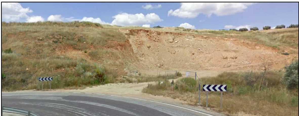
Figura nº 115: Fotografía estado actual del acceso a la explotación
