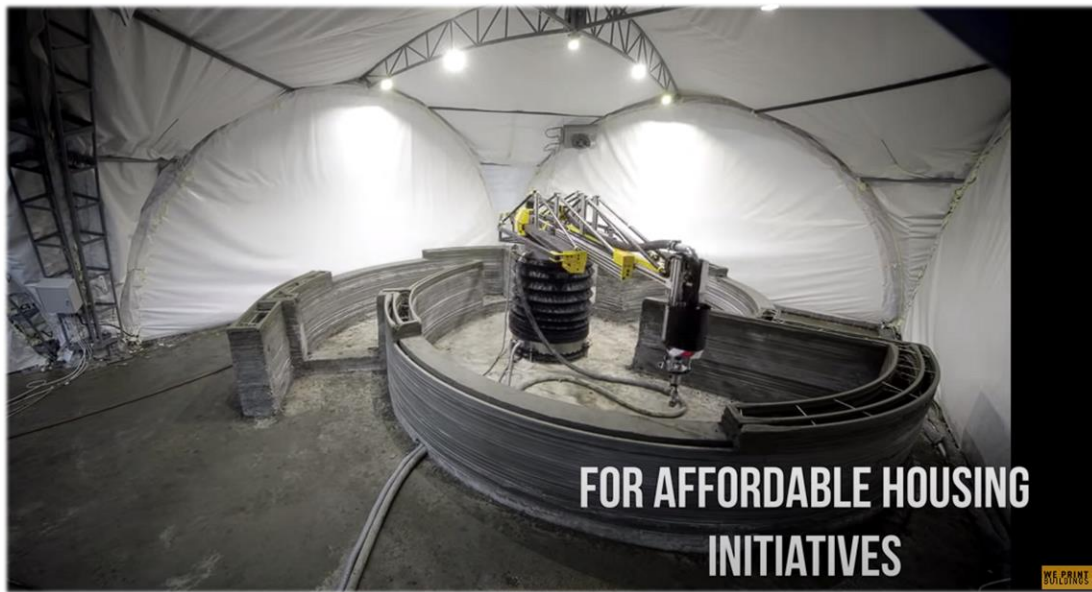
Figura 2.5: Tecnología de impresión 3D para edificios, desarrollada por Apis Core en proyectos desarrollados en California y Louisiana.
