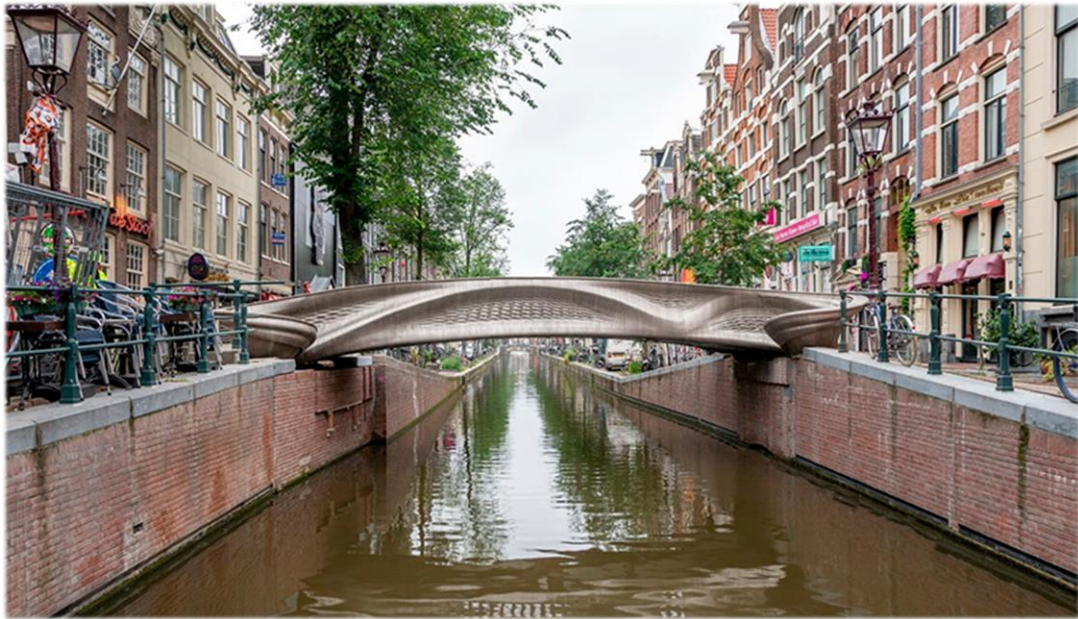
Figura 2.4: Puente de acero inoxidable producido mediante impresión 3D por Adriaan de Groot / MX3D.
