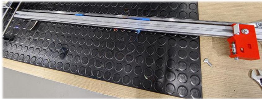
Figura 5.58: Montaje de carril MGN 12H sobre pieza de PLA y tacos soporte.
