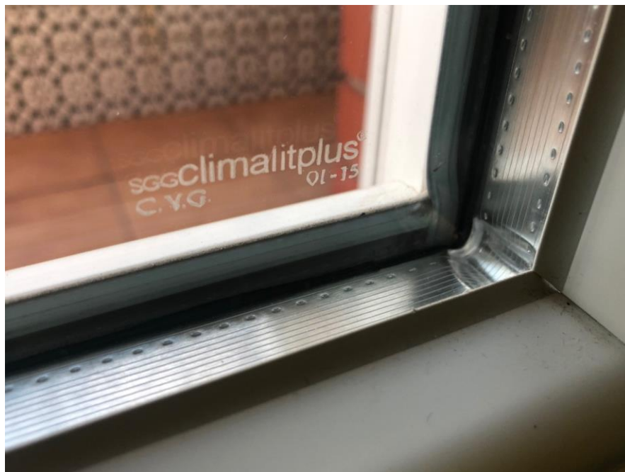
Figura 10. Detalle marco cerramientos de PVC, tipo de vidrios SGG CLIMALITPLUS SAFE y cámara de aire deshidratada con perfil separador de aluminio.
