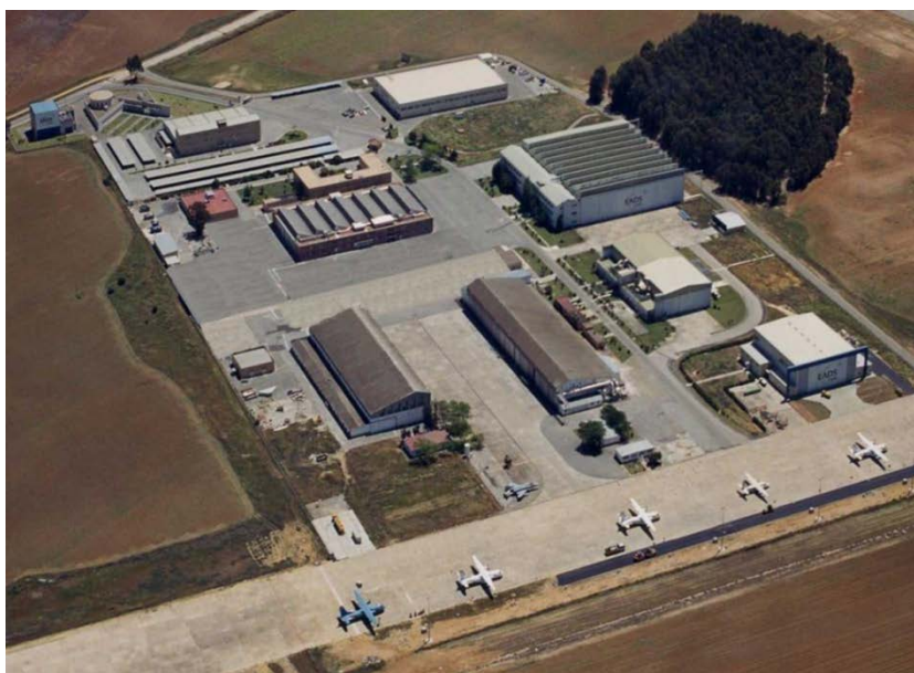
Figura 3: Localización de la planta San Pablo Norte centro de mantenimiento y reparación (Fuente: MRO SPN)
