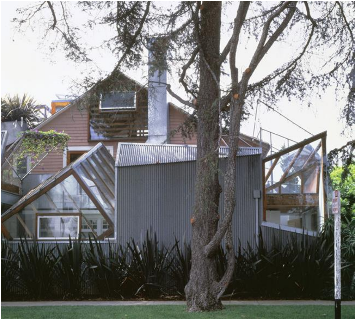
1. Casa de Frank Gehry
