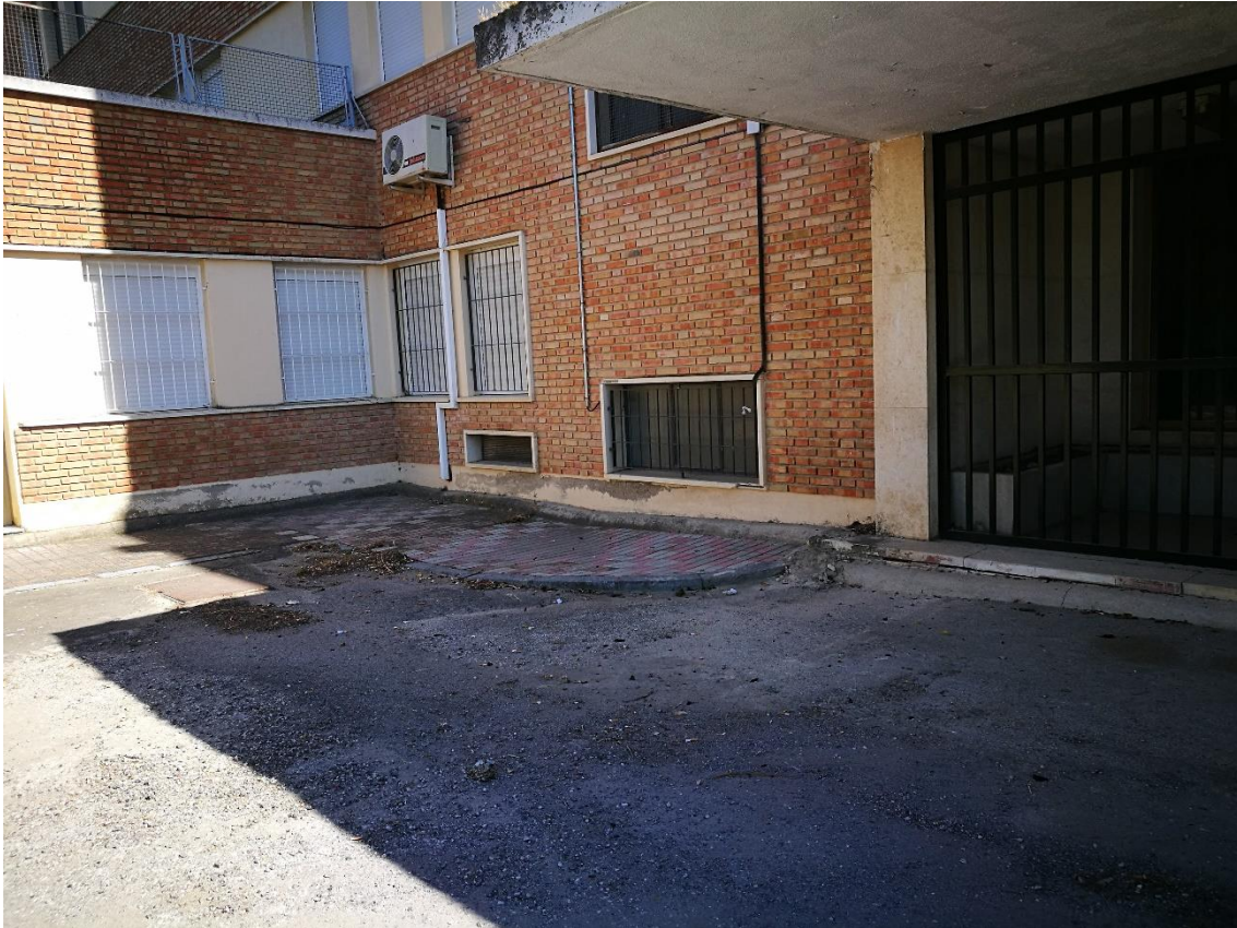
Figura 42. Hundimiento del edificio desde toma real.
