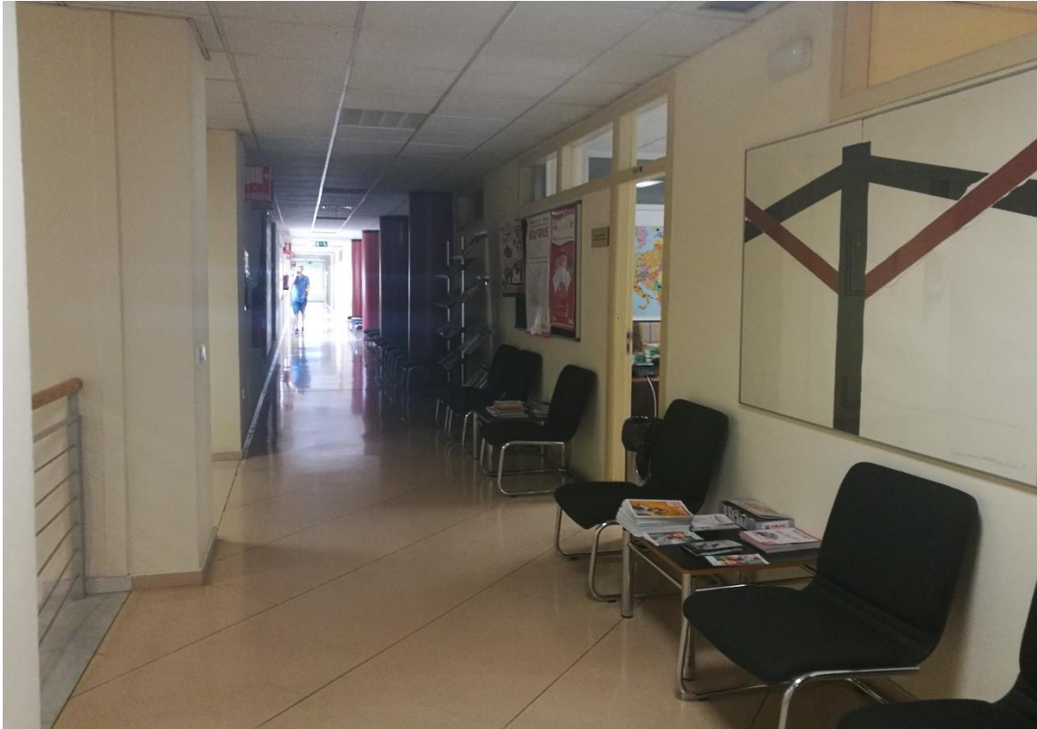
Figura 52. Columnas pasillo izquierdo de la entrada principal en la primera planta.
