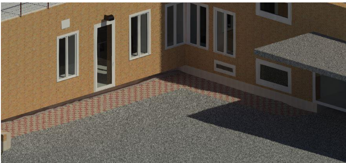
Figura 22. Hundimientos del edificio visualizado con render.
