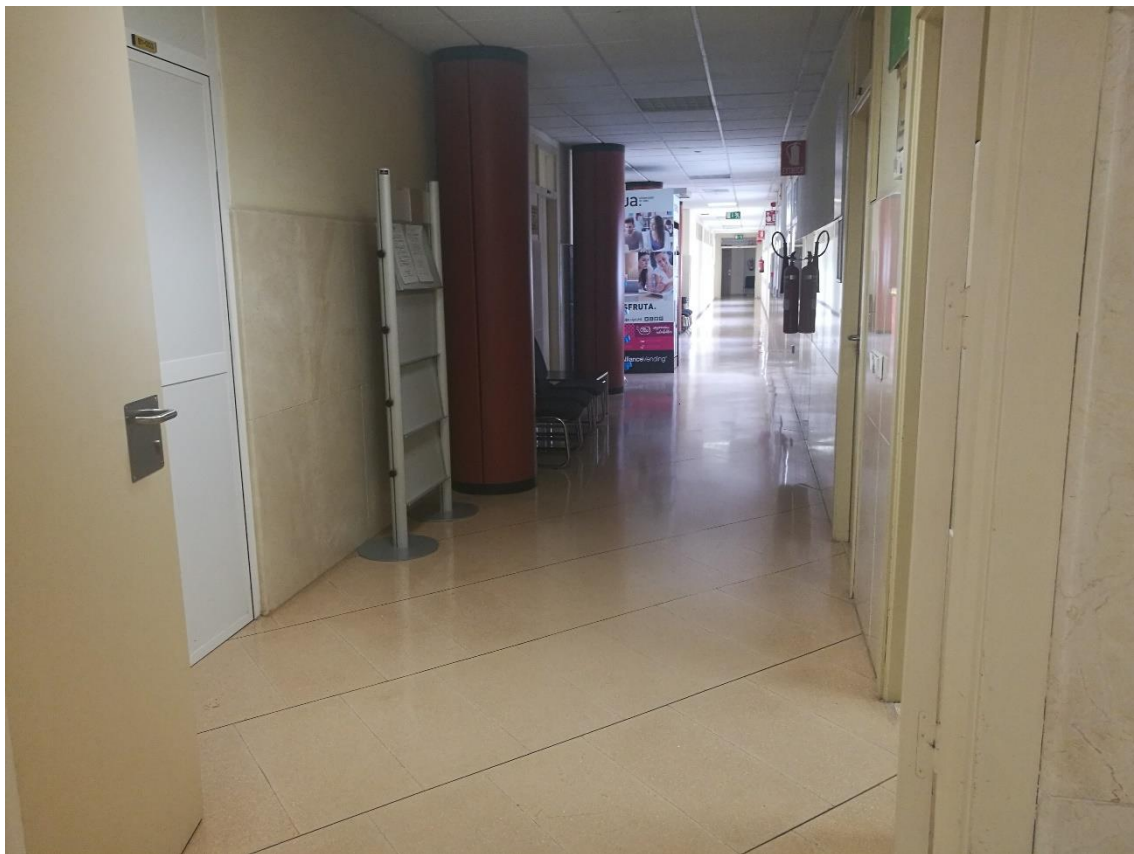
Figura 50. Columnas pasillo izquierdo de la entrada principal en la planta baja.
