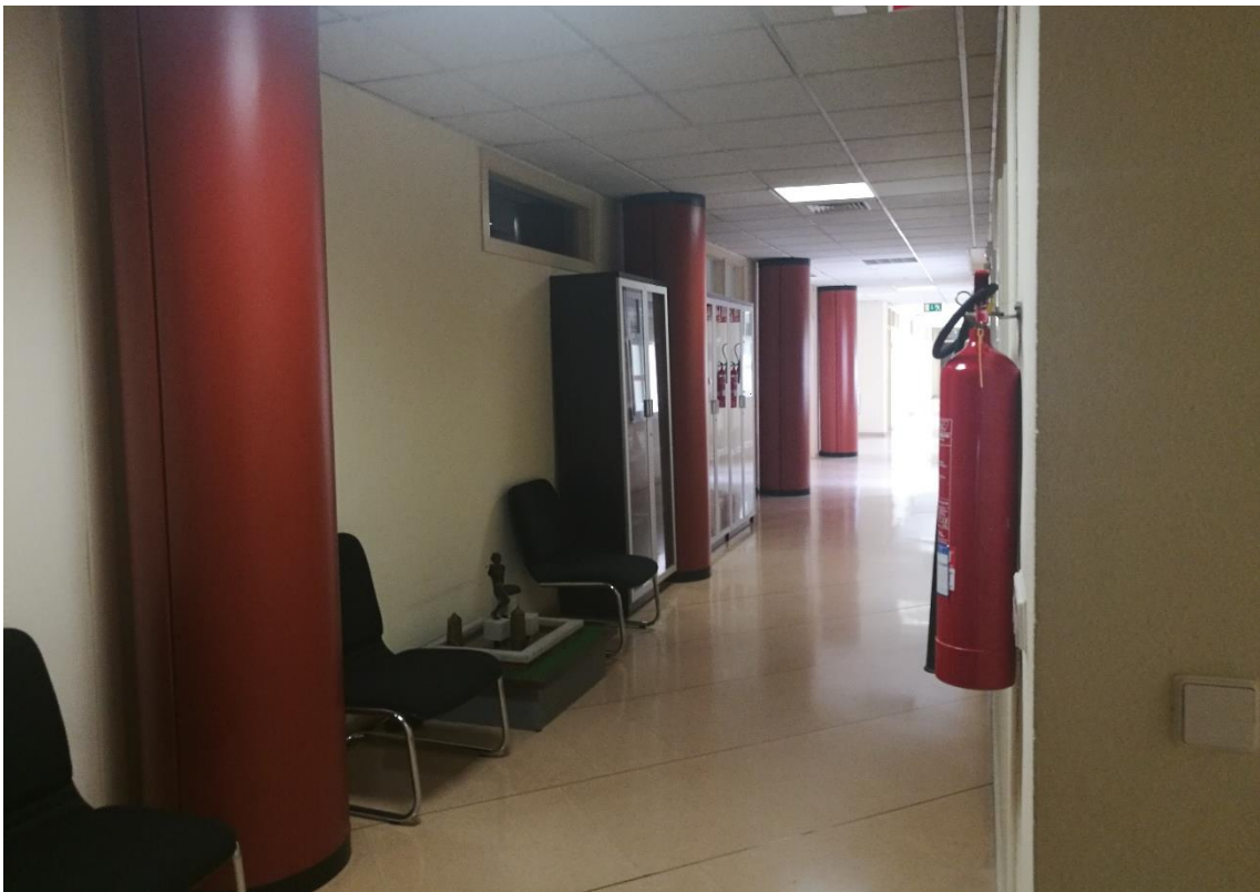
Figura 53. Columnas pasillo derecho de la entrada principal en la primera planta.
