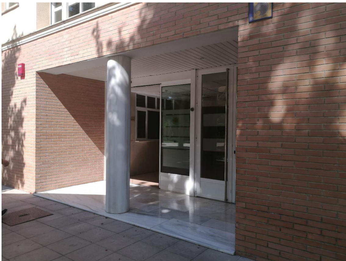
Figura 46. Exterior de la entrada principal de la planta baja.
