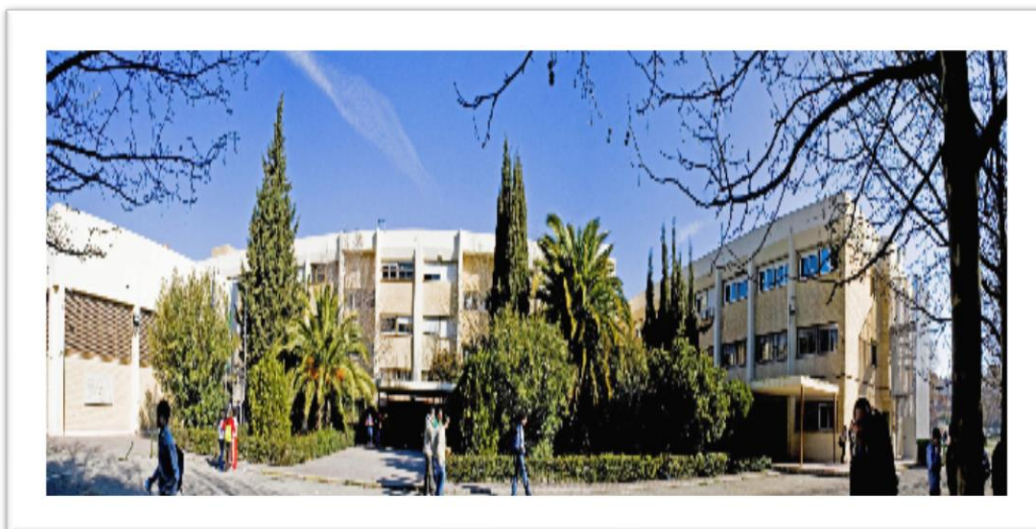
Imagen 12: IES Las Fuentezuelas. Fuente: http://www.ieslasfuentezuelas.com/
