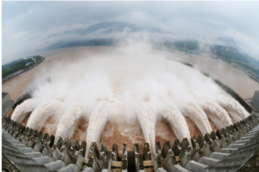
Figura 2.10 Presa de las Tres Gargantas
