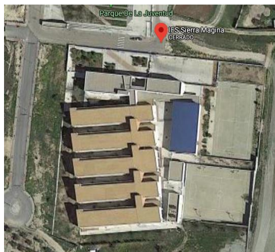
Ilustración 12. Vista satélite instituto (Fuente: Google Maps, 2021)
