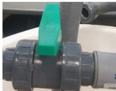
Imagen 47: Válvula de paso
