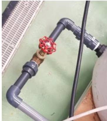
Imagen 26: Válvula de entrada
