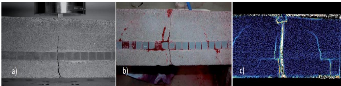
Ilustración 1. a) Escalón de hormigón tras ser sometido a prueba de carga. Muestra una gran grieta [4].
