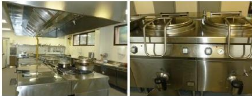
Fig. 8-25: Equipos de cocina a gas propano
