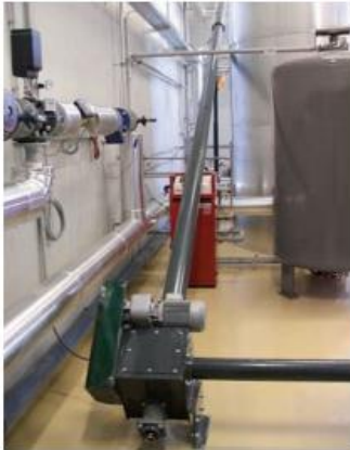
Fig. 14-4: Ejemplo sistema central de evacuación de cenizas central mediante sinfín
