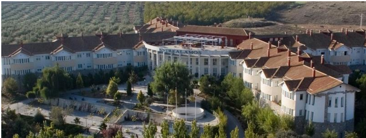
Fig. 8-20: Cubierta de la Residencia
