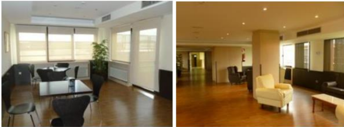
Fig. 8-4: Luminarias halógenas dicróicas
