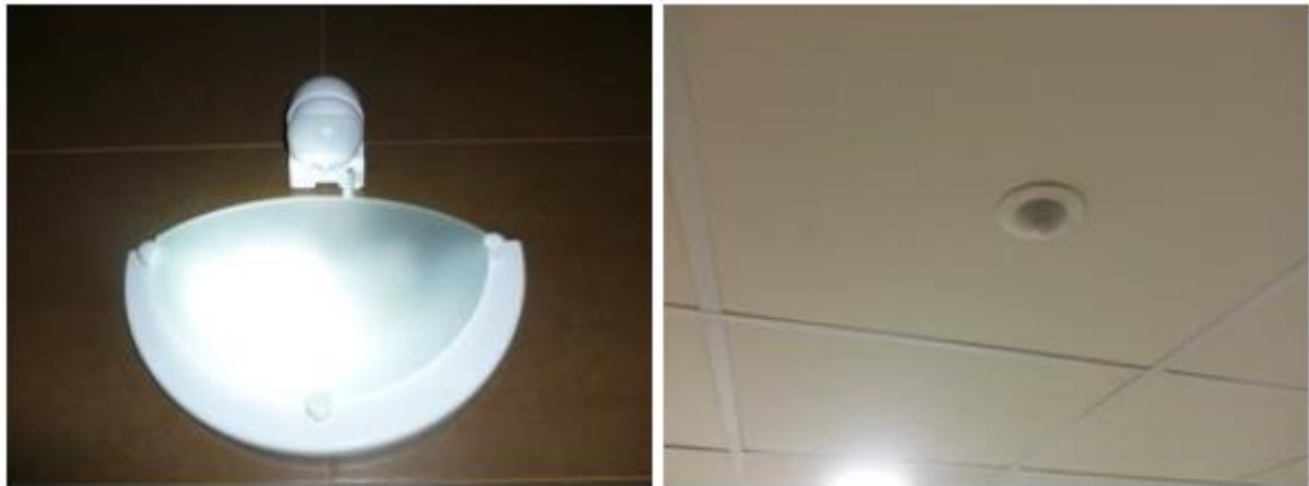
Fig. 8-3: Detectores de presencia
