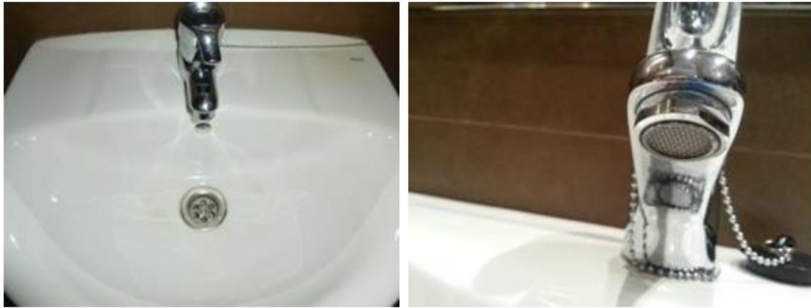
Fig. 8-16: Grifería dotada de perlizadores
