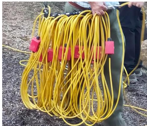
Fig. 37 Tirada de cableado sobre el terreno.
