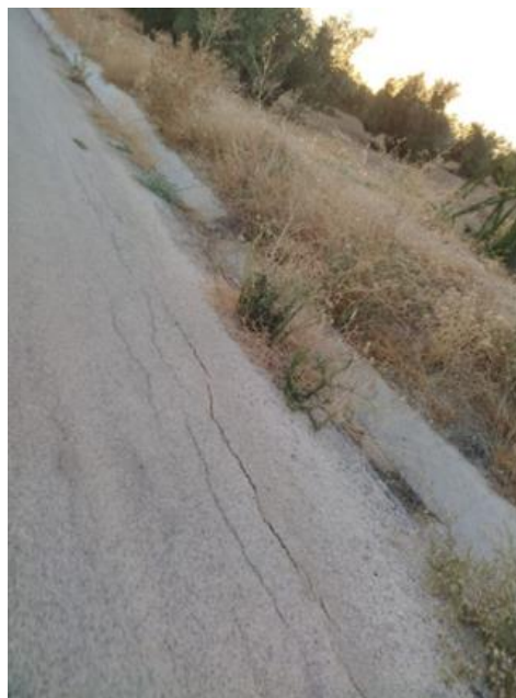
Figura 10: Cunetas con vegetación
