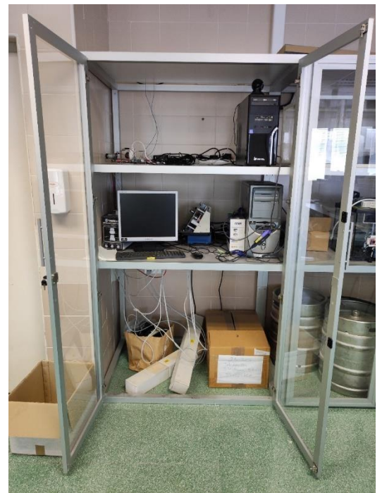
Figura 1-5.- Armario laboratorio remotos (abierto)
