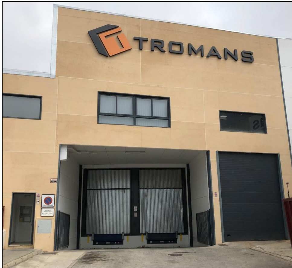
Figura 4.3. Nave Aftermarket (Fuente: Fotografía del autor)
