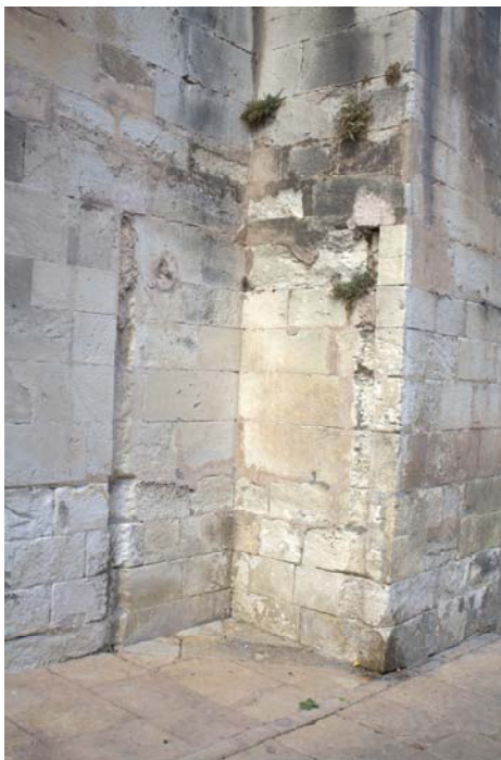
Figura 23. Hendiduras verticales sin identificar en la cabecera (e.p).
