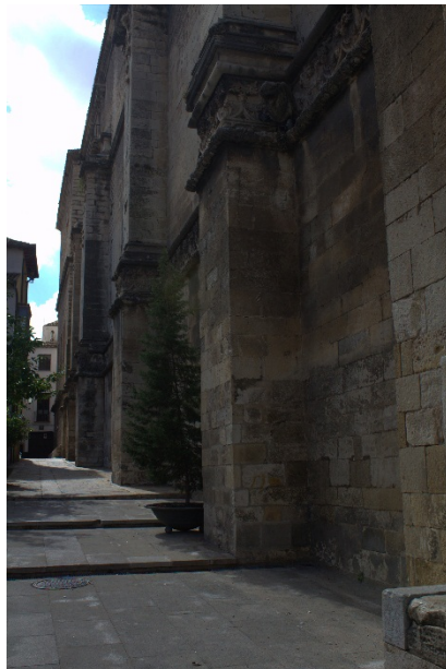
Figura 6. Contrafuertes y muro de la cabecera de la Catedral de Jaén. (e.p.)
