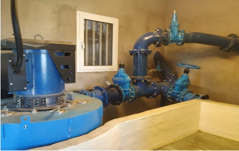
Figura 10. Turbina Pelton
