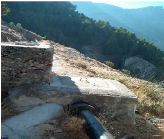
Figura 4. Canal de derivación enterrado
