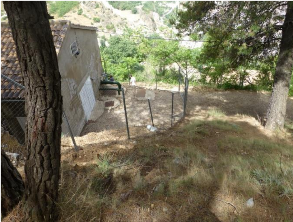
Figura 9. Edificio central y potabilizadora
