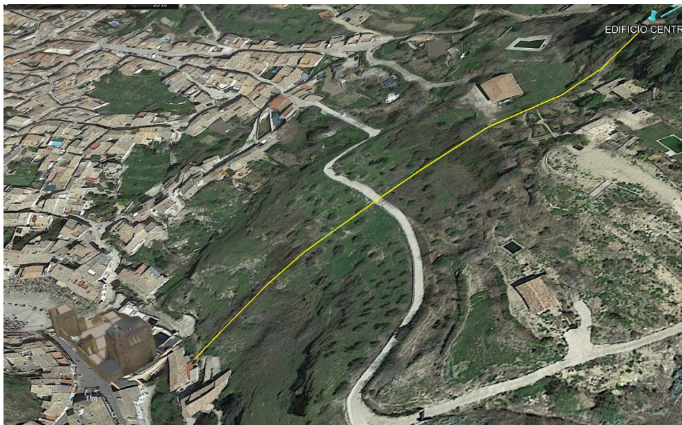
Figura 16. Línea de baja tensión superficial bajo tubo (Fuente: Elaboración Propia)
