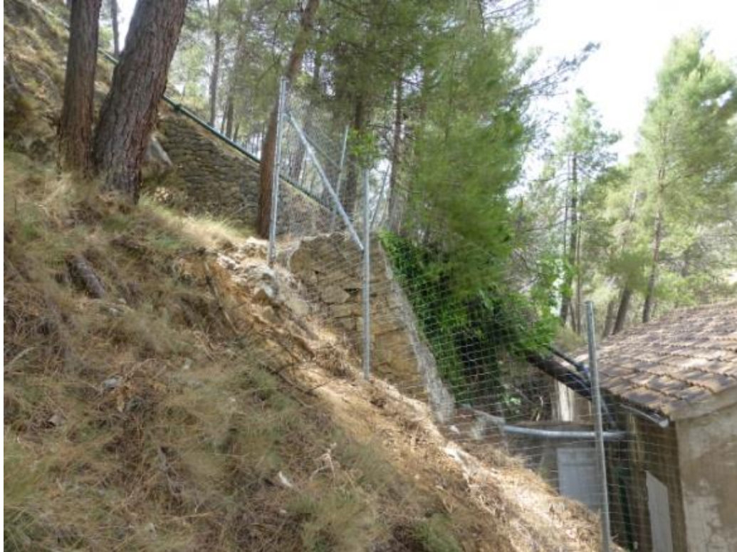
Figura 8. Detalle perfil tubería-potabilizadora
