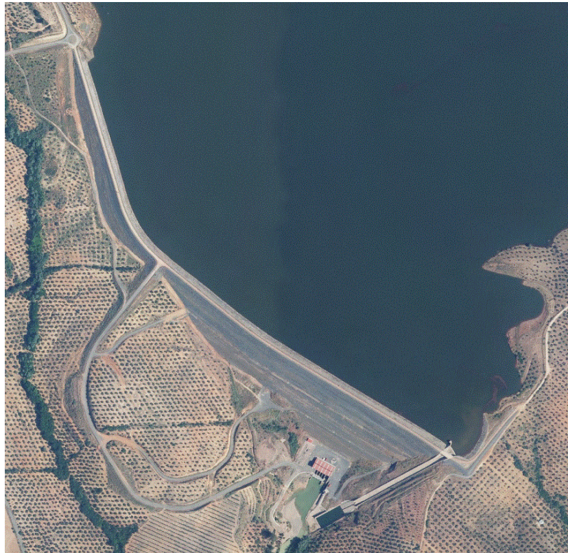
Figura 13.- Ortofotografía PNOA de la Presa del Arenoso
