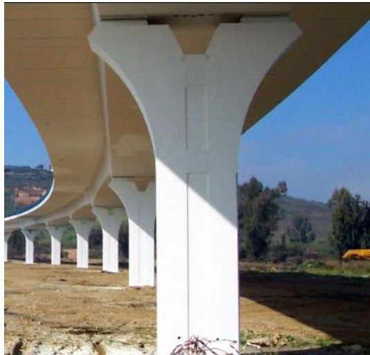
Figura 3. 4. Dintel con doble apoyo
