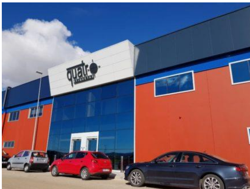
Figura 5: Fachada actual de la empresa Quatro Etiquetas S.L. Fuente: Urbiferga.
