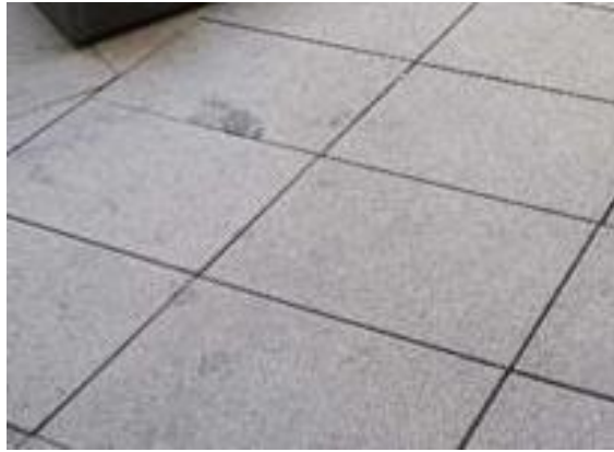
Imagen 11.2: Suelos, solerías, pavimentos.
