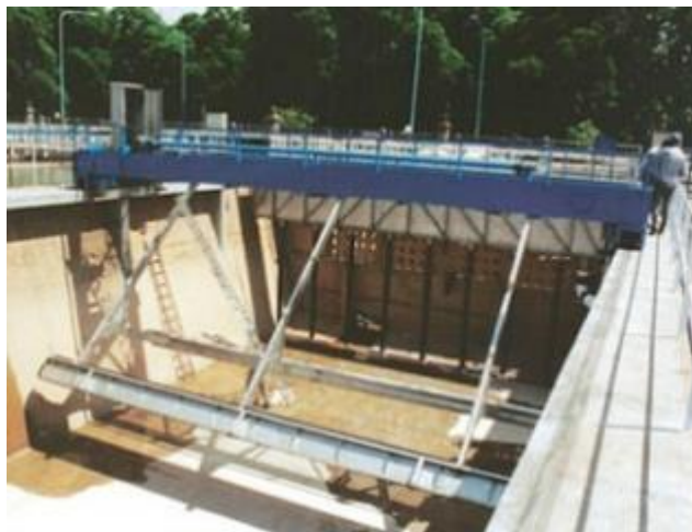
Imagen 8.1: Depósito de sección rectangular.
