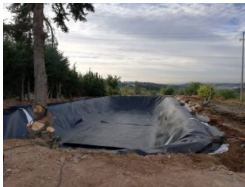
Figura 9.7: Colocación de geotextil [6]
