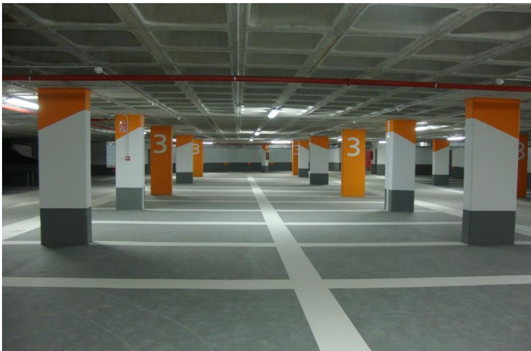
Fig. 1. Aparcamiento con forjado reticular
