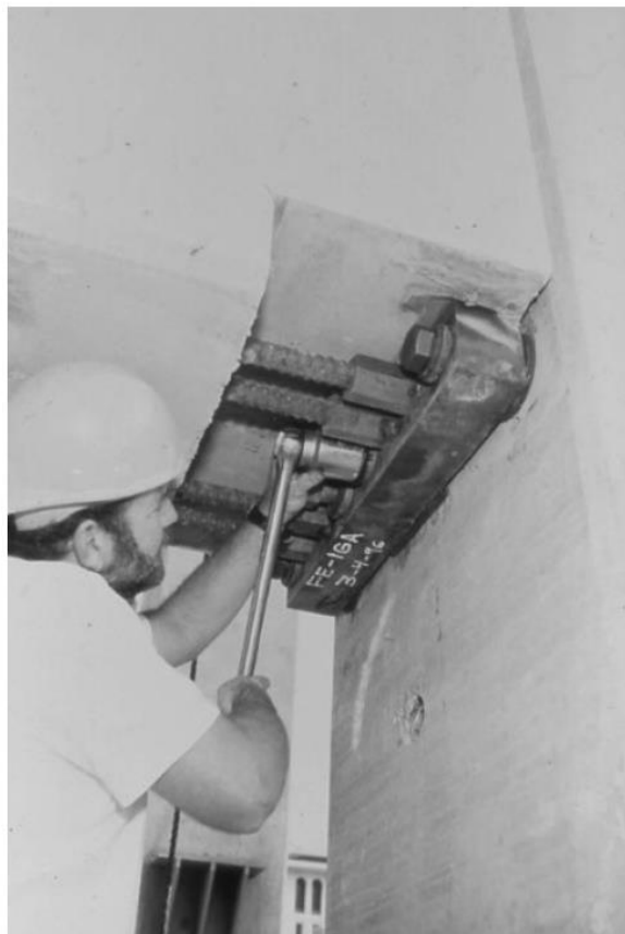
Fig. 58. Ejecución del par de apriete de los tornillos (Ref. [2])
