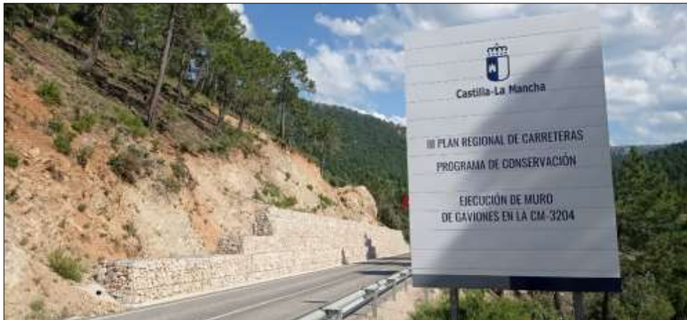
Fig. 22: Muro de contención en la carretera CM-3204. Elaboración propia.
