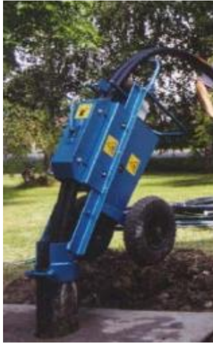
Figura 22. Introducción de las sondas geotérmicas.
