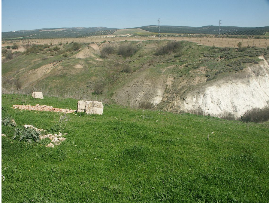
Figura 13. Lenguas de deslizamiento en la desembocadura del Arroyo de la Minilla.
